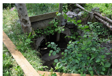
Vue de l'ancien canal. Phot. Clara Bérelle IVR82_20137301958NUCA
