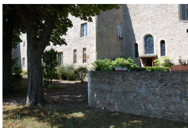
Vue d'une partie des bâtiments et de la chapelle depuis l'est. Phot. Caroline Guibaud IVR82_20154200373NUCA
