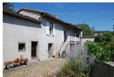
Vue sur l'atelier depuis le sud-est. Phot. Caroline Guibaud IVR82_20154200420NUCA
