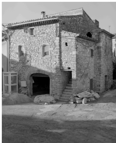
Façade en cours de restauration.
