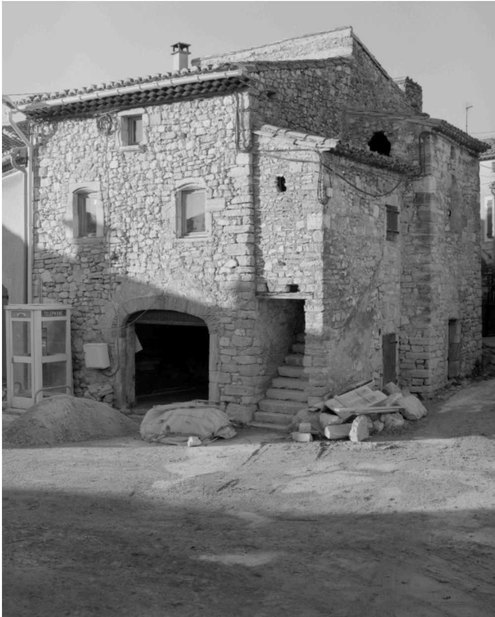
Façade en cours de restauration.
