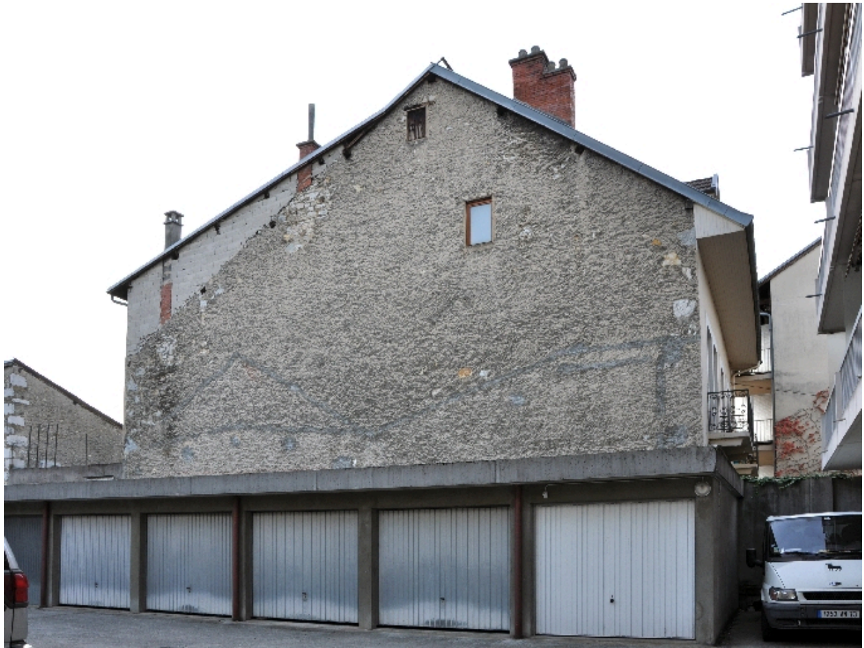
Garages dans la cour
