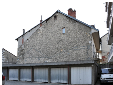
Garages dans la cour Phot. François Fouger IVR82_20097301082NUCA
