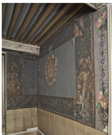
La petite chambre : le papier peint du mur de droite Phot. Eric Dessert IVR82_20076901350NUCA
