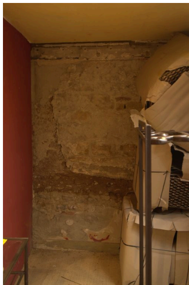
Détail d'un mur en pisé Phot. Laurent Lascoux IVR82_20026904613NUCA
