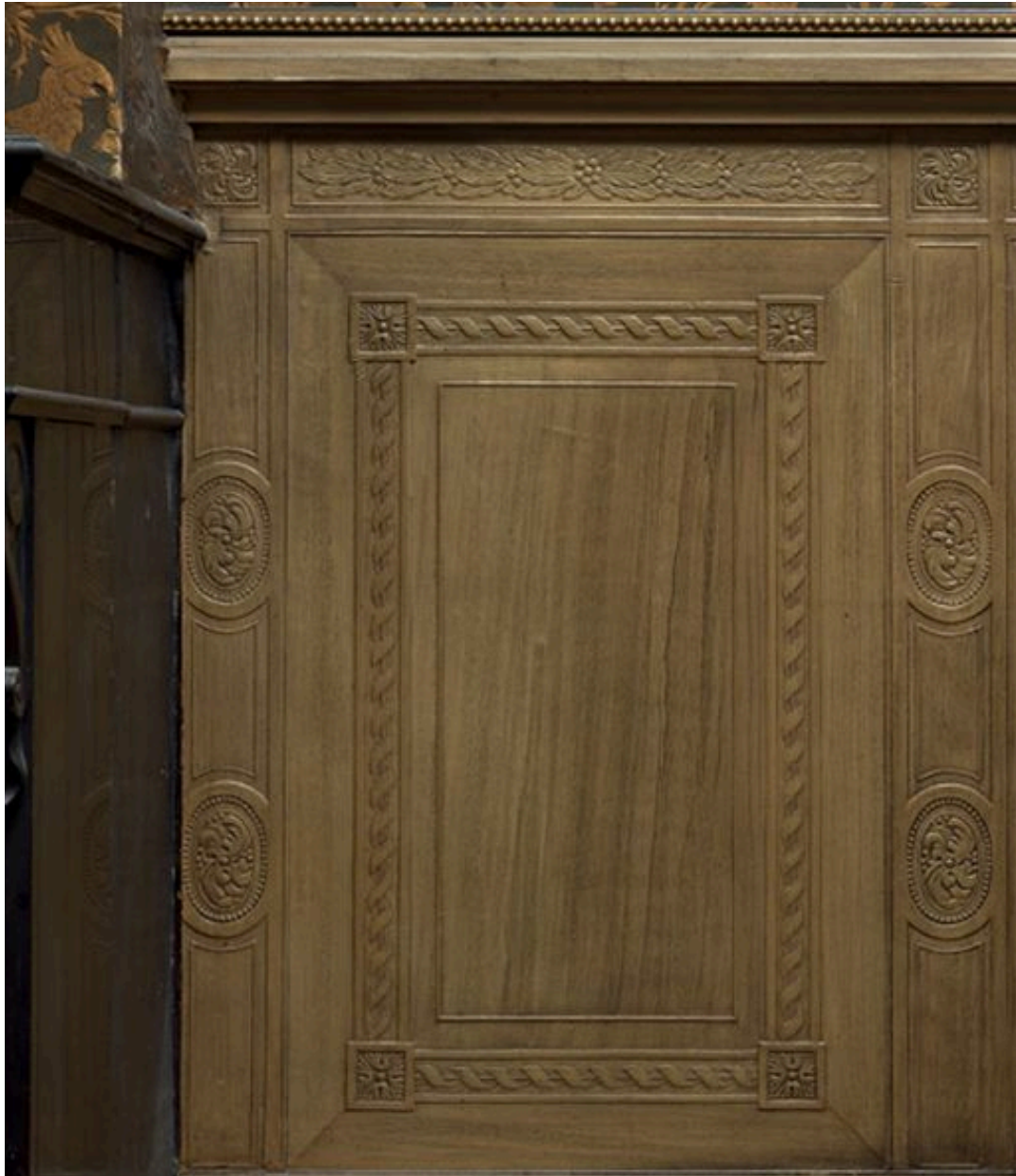
La grande chambre : détail du lambris de hauteur
