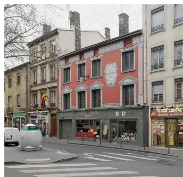
Vue d'ensemble après restauration Phot. Eric Dessert IVR82_20096900256NUCA
