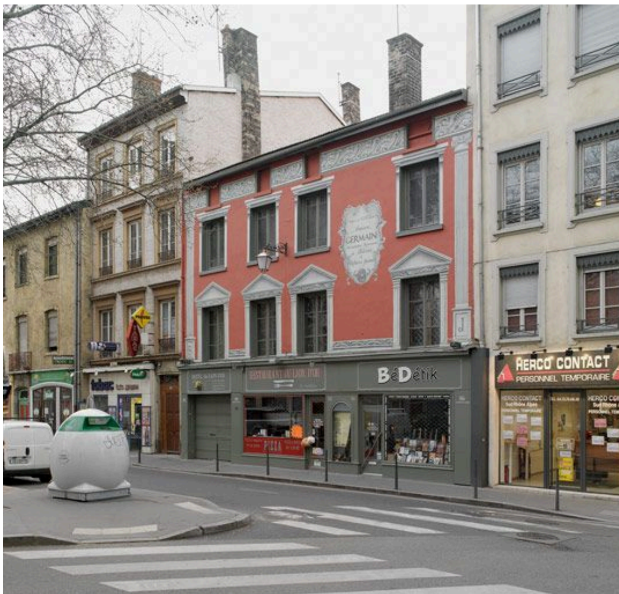
Vue d'ensemble après restauration
