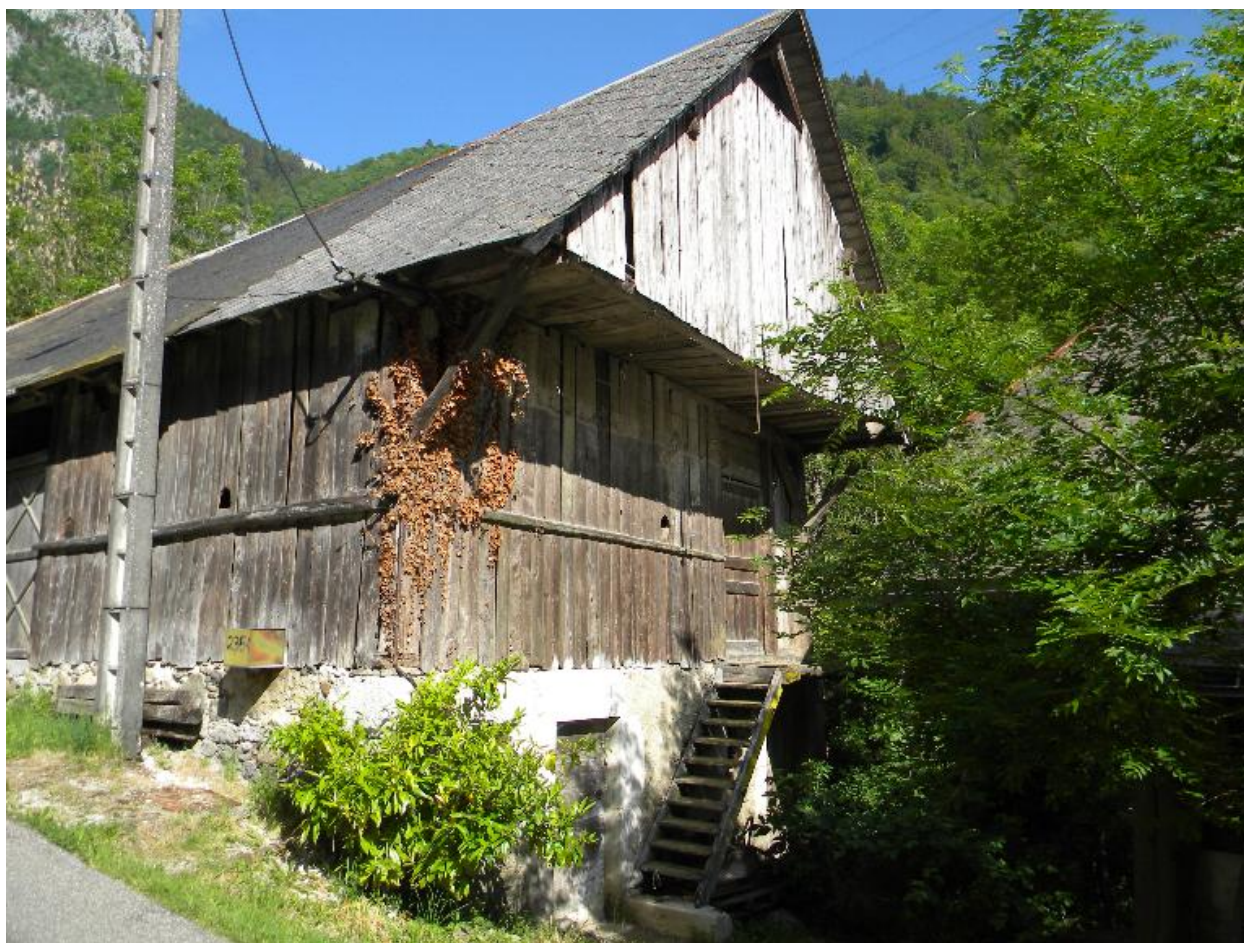
Vue de trois-quarts depuis la route de Marceau.
