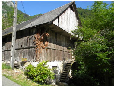
Vue de trois-quarts depuis la route de Marceau. Phot. Jérôme Daviet IVR82_20147400418NUCA
