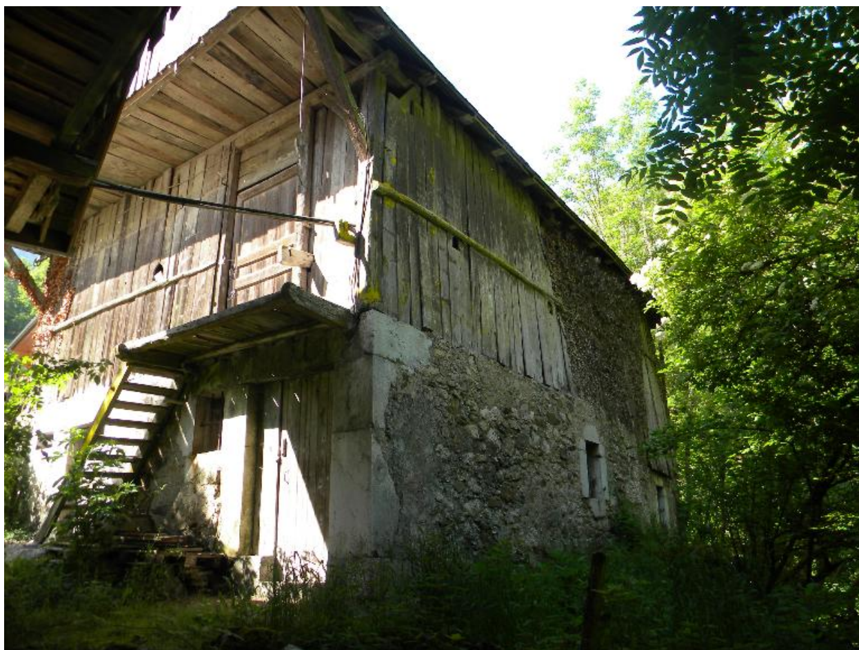
Vue de trois-quarts depuis la rivière
