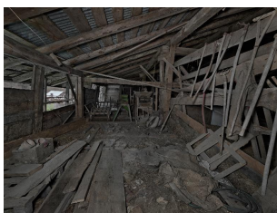
Vue intérieure du comble, depuis l'ouest.
