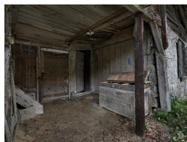
Partie est : porte d'entrée de l'habitation et porte du cellier ou étable ; coffre à grain devant le mur en retour. Phot. Eric Dessert IVR84_20187401145NUCAQ
