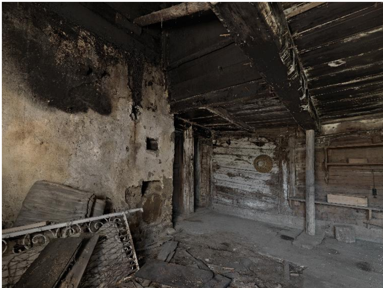
Partie est, vue intérieure de la cuisine (cheminée, cloison en bois).
