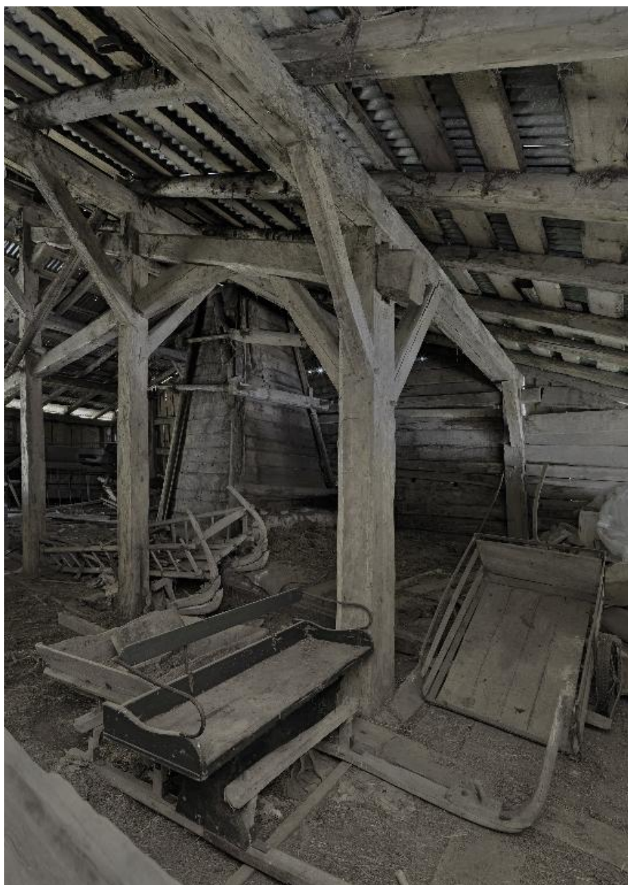
Partie est, vue intérieure du comble (charpente, conduit de la cheminée).
