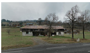
Vue d'ensemble depuis le sud-est : façade principale. Phot. Eric Dessert IVR84_20187401125NUCAQ
