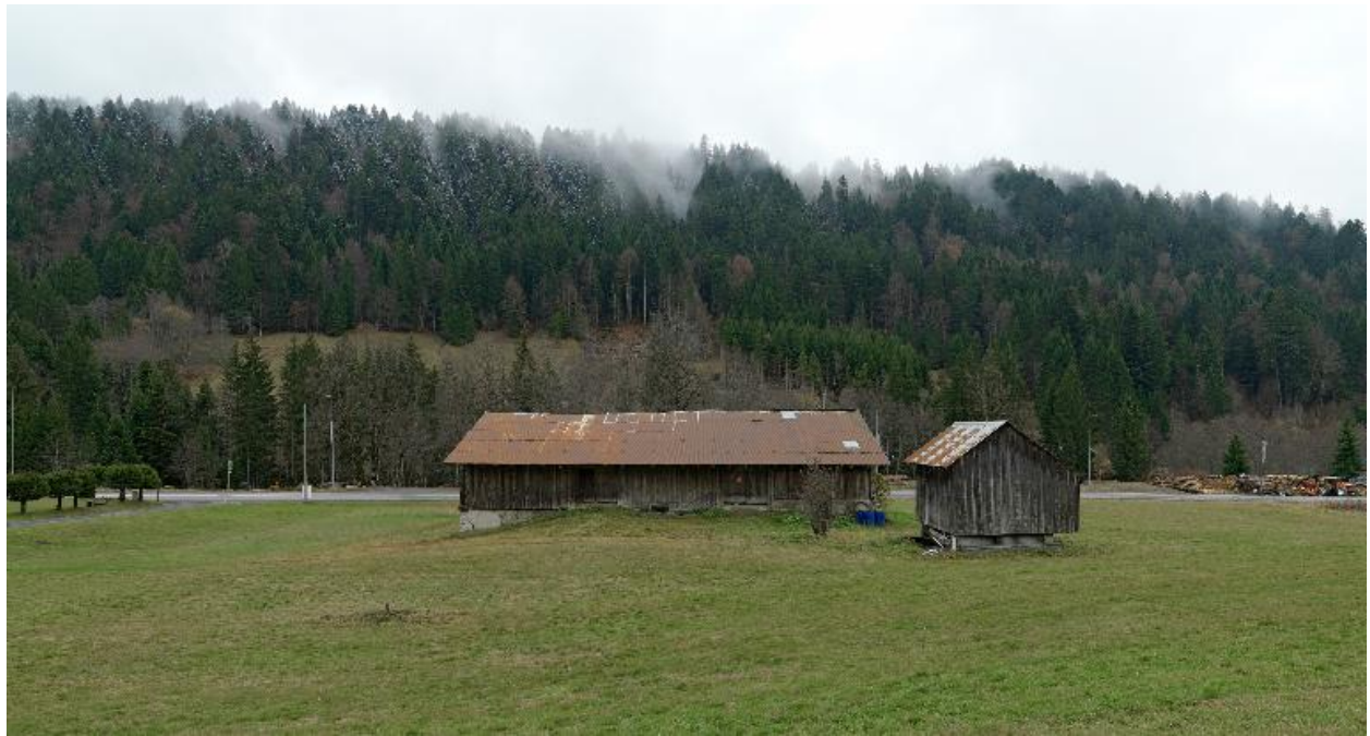
Vue d'ensemble depuis le nord-ouest : façade postérieure.
