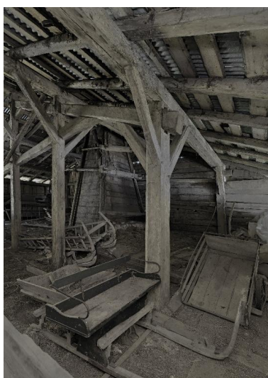
Partie est, vue intérieure du comble (charpente, conduit de la cheminée). Phot. Eric Dessert
