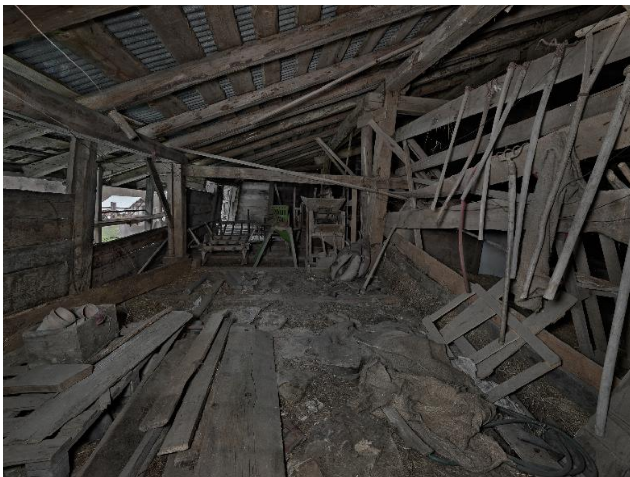
Vue intérieure du comble, depuis l'ouest.
