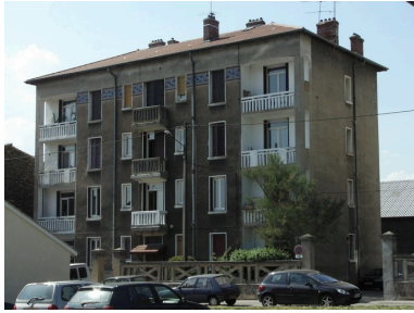
façade sud est Phot. Benoît Chapelle IVR82_20073800063NUCA
