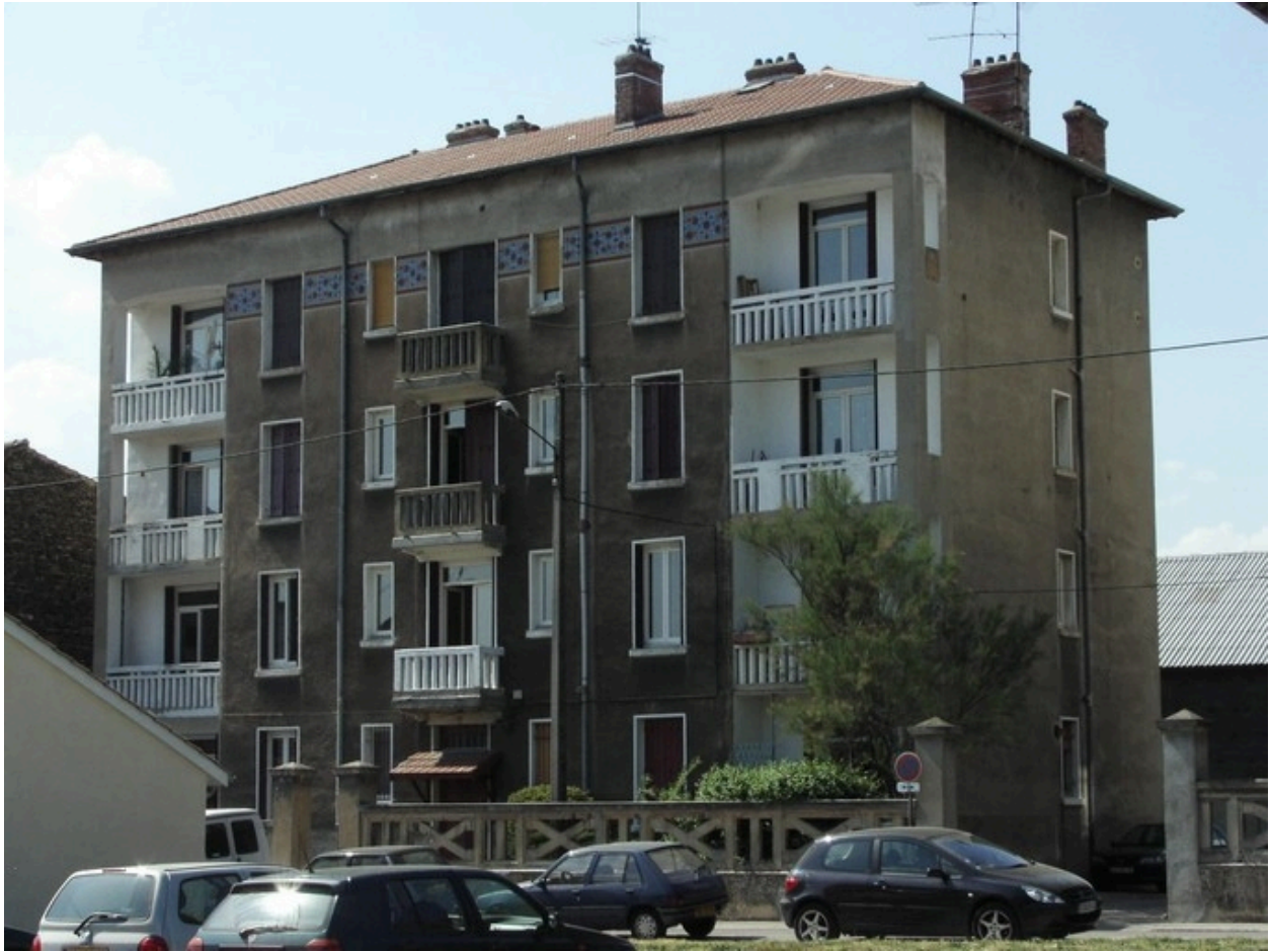
façade sud est
