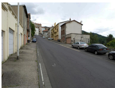
Partie inférieure de l'avenue Philippe-Dufour, en direction du sud-est. Phot. Jean-Michel Périn IVR83_20116300670NUC4A
