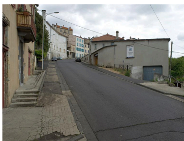
Partie médiane de l'avenue Philippe-Dufour, en direction du sud-est, avec aménagement de trottoir en emmarchements. Phot. Jean-Michel Périn IVR83_20116300671NUC4A
