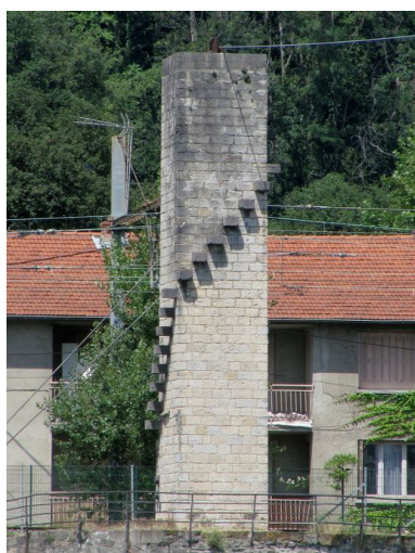
Pile droite, face est, vue générale (depuis la rive gauche) Phot. I. Havard IVR82_20106907043NUCA
