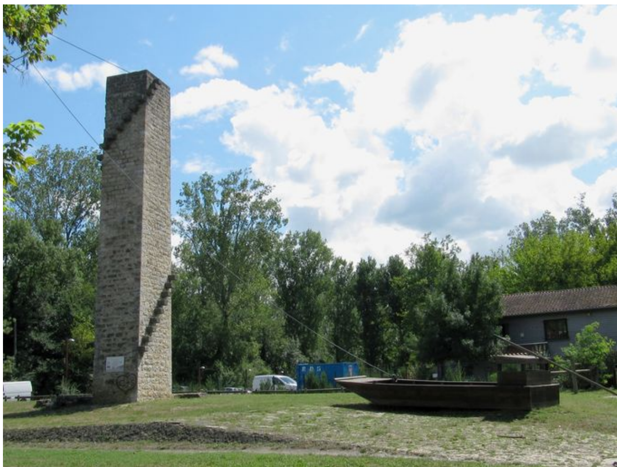
Pile gauche, angle sud-ouest, vue générale avec les câbles (depuis la rive gauche)
