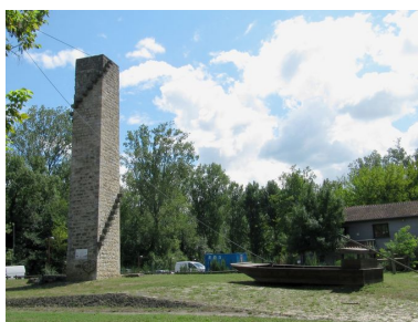
Pile gauche, angle sud- ouest, vue générale avec les câbles (depuis la rive gauche) Phot. I. Havard IVR82_20106907046NUCA
