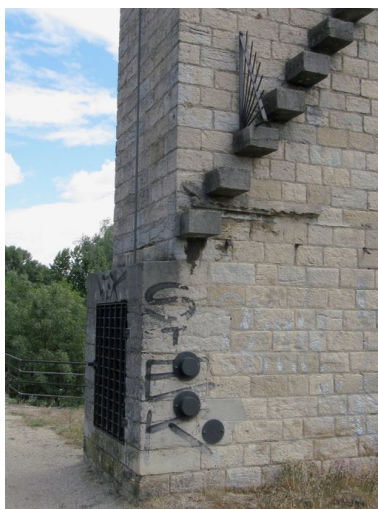
Pile droite, face sud, vue partielle : base avec le treuil (depuis la rive droite)
