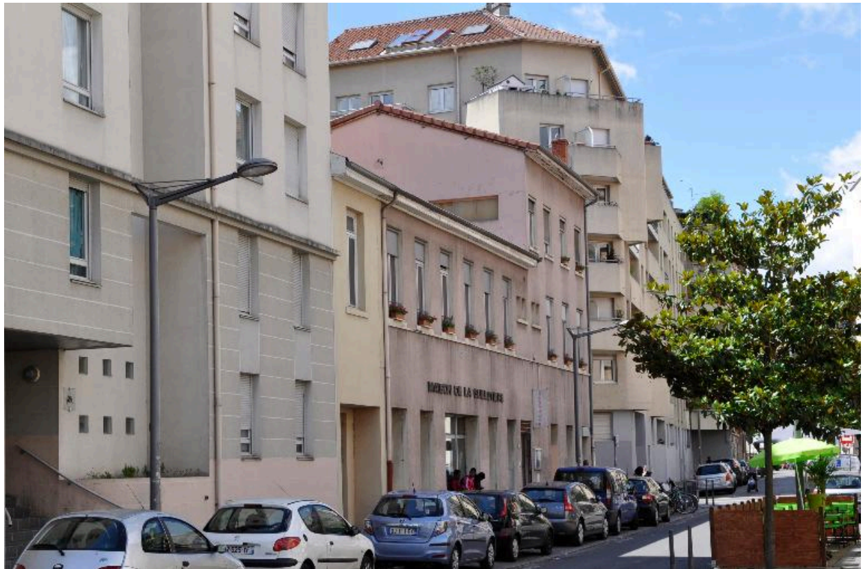
Vue d'ensemble des élévations sur la rue Béchevelin
