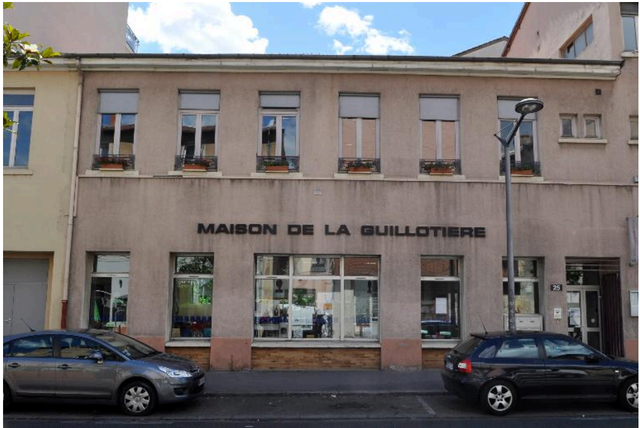
Vue du bâtiment bas au 25, rue Béchevelin
