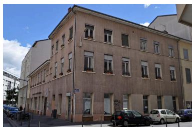
Vue d'ensemble, depuis l'ouest Phot. Catherine Guégan IVR84_20166900539NUCA
