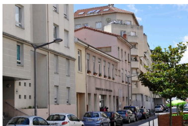
Vue d'ensemble des élévations sur la rue Béchevelin Phot. Catherine Guégan IVR84_20166900541NUCA
