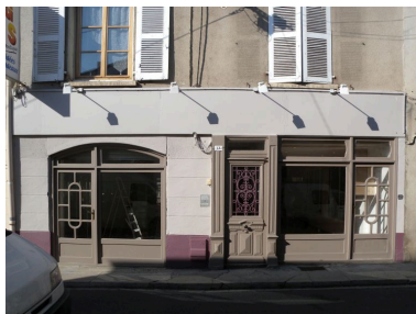
Vue du rez-de-chaussée.
