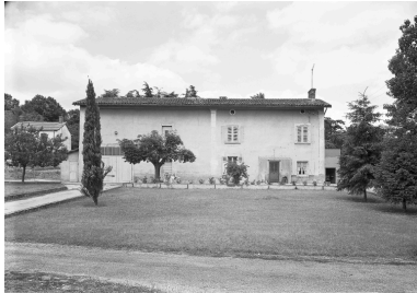
Elévation antérieure. Phot. Jean-Marie Refflé IVR82_19910100645P
