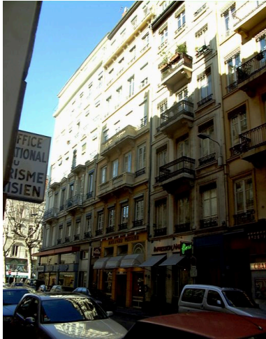
Façade sur rue, vue générale Phot. Bernard Ducouret IVR82_20016900826NUCA
