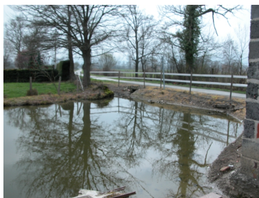
Vue de la mare-abreuvoir. Phot. Thierry Monnet IVR82_20134204210NUCA
