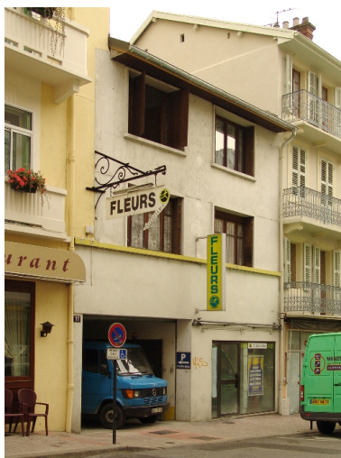
Façade sur la rue de Chambéry Phot. François Fouger IVR82_20067300752NUCA
