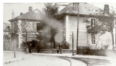
Vue depuis la rue, début XXe siècle Repro. François Fouger IVR82_20117300385NUCB
