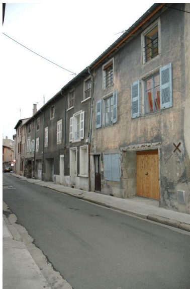
Vue de situation (1ère maison à droite). Phot. Simone Hartmann-Nussbaum IVR82_20114201287NUCA
