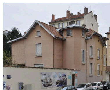
Vue générale prise du nord-est Phot. Magali Delavenne IVR82_20156902703NUCA
