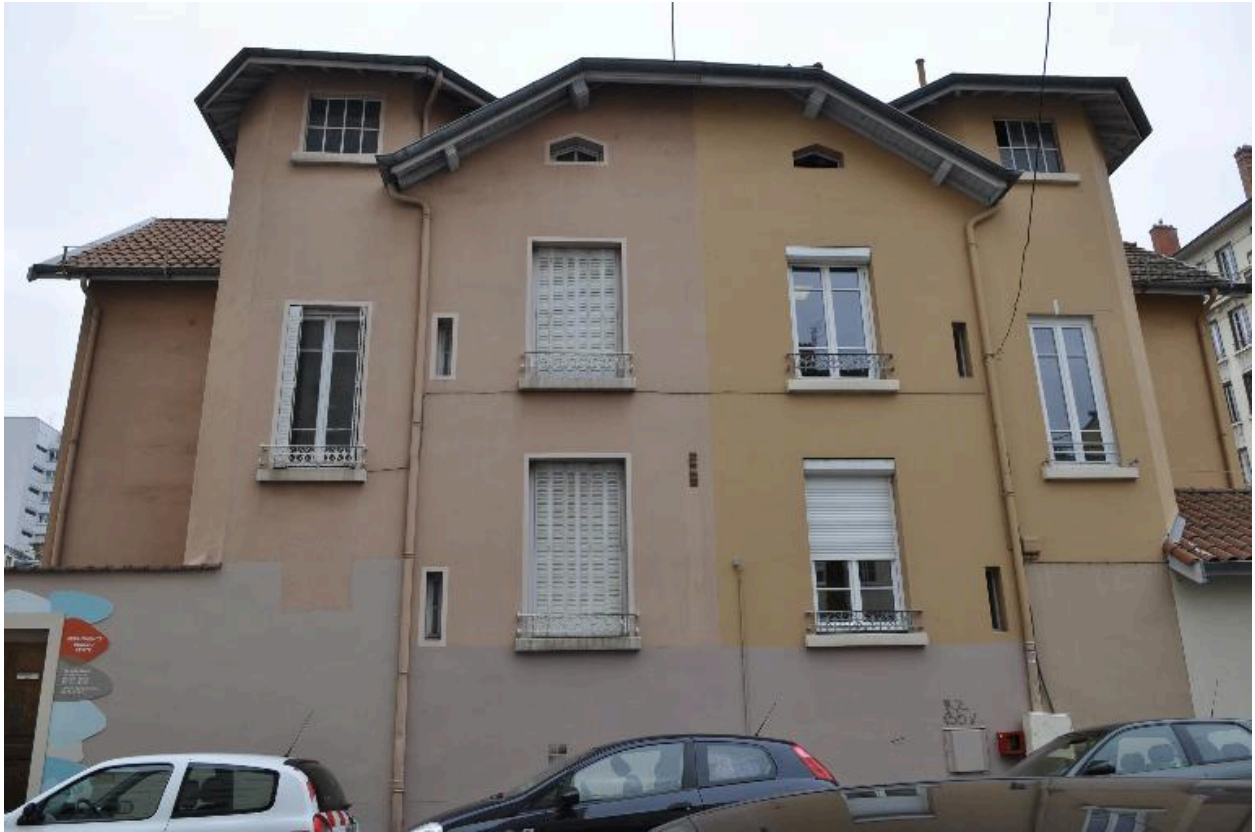
Vue de la façade nord
