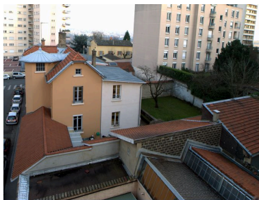
Vue de la façade ouest de la maison et des ateliers à sheds du n°4 rue Claudius-Linossier Phot. Catherine Guégan IVR82_20096900551NUCA
