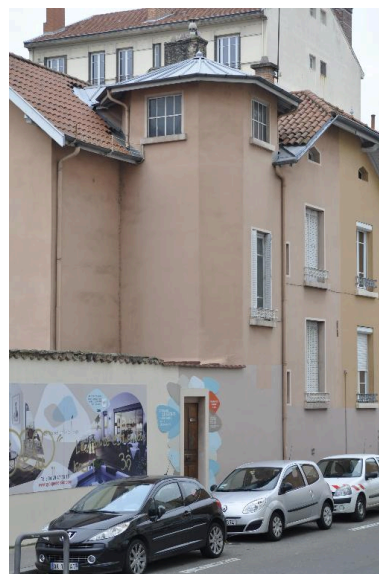
Vue rapprochée de la tourelle d'angle est Phot. Magali Delavenne IVR82_20156902705NUCA
