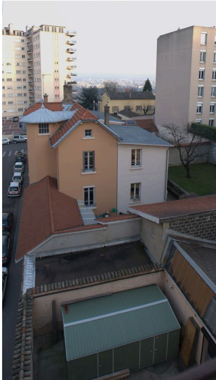
Vue de la façade ouest de la maison, des bâtiments annexes et de la cour du n°4 rue Claudius-Linossier
