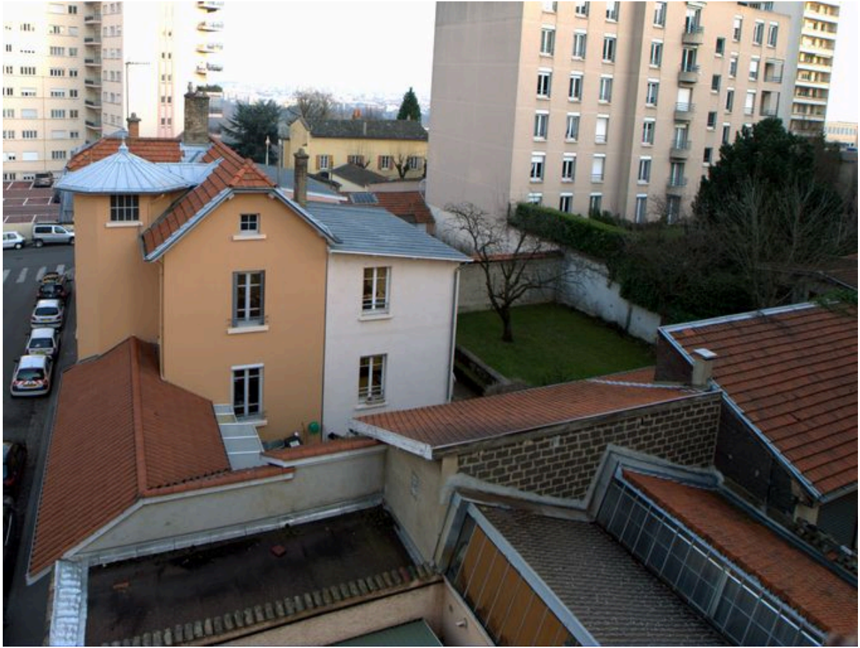
Vue de la façade ouest de la maison et des ateliers à sheds du n°4 rue Claudius-Linossier
