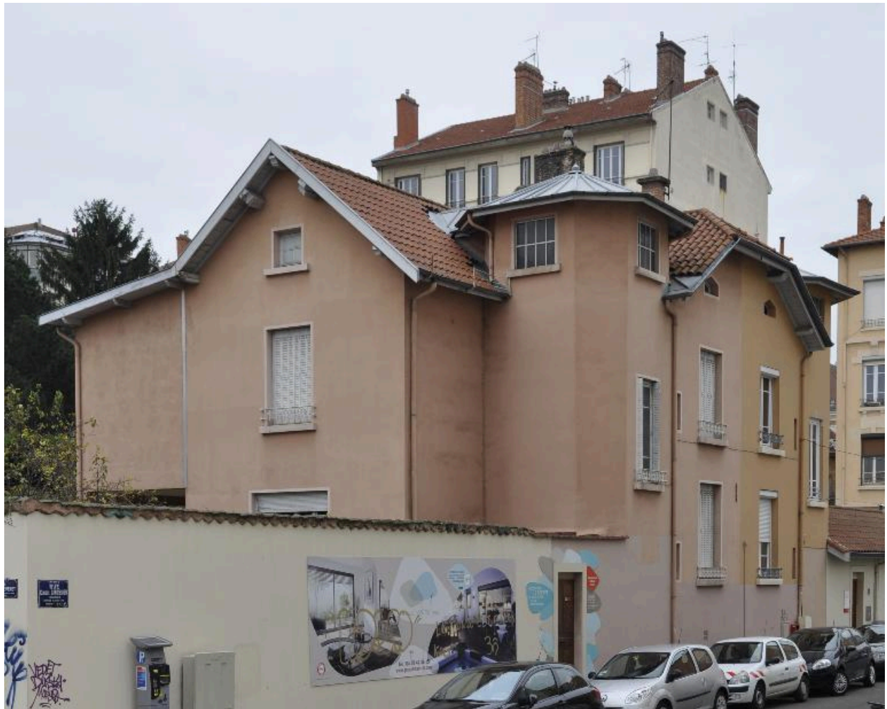
Vue générale prise du nord-est
