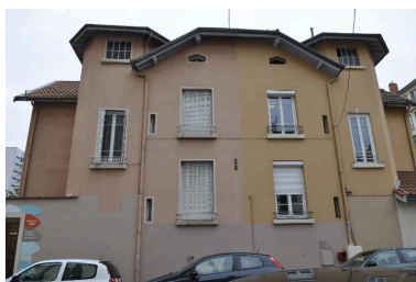
Vue de la façade nord Phot. Magali Delavenne IVR82_20156902706NUCA
