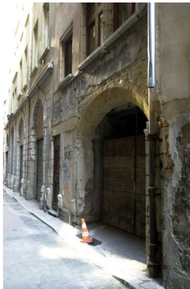
Façade, détail du rez-de-chaussée Phot. Bernard Ducouret IVR82_20046900006NUCA
