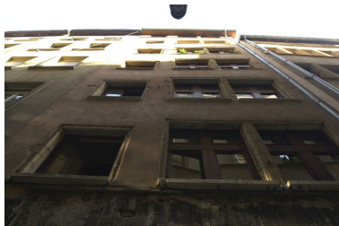
Façade, vue des étages Phot. Bernard Ducouret IVR82_20046900007NUCA
