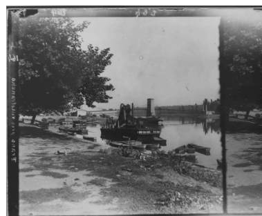
Frans près Francheville. Le pont et le port vus depuis la rive droite. Photogr. par [Berthier], vers 1900, plaque de verre. Repro. Jean-Marie Refflé IVR82_19900100066XB
