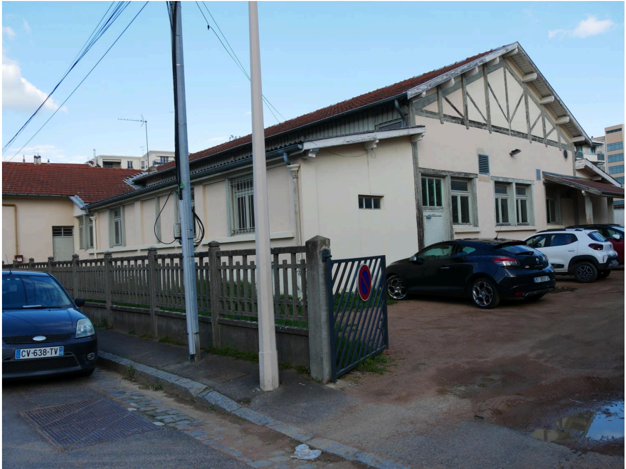
Vue pignon nord
