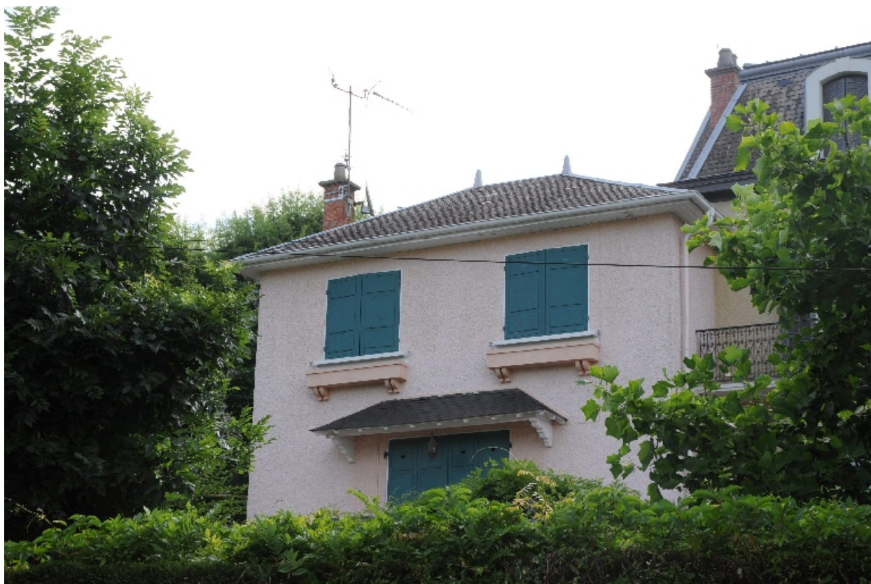
Pavillon nord, élévation occidentale
