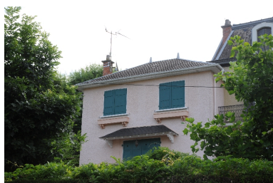
Pavillon nord, élévation occidentale Phot. François Fouger IVR82_20127300092NUCA
