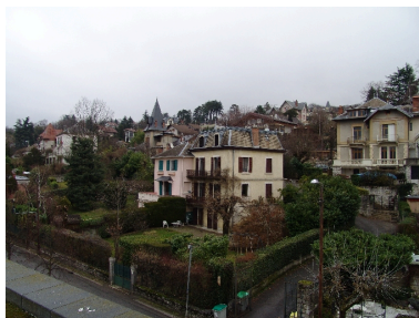
Vue d'ensemble depuis le collège Jean-Jacques Perret Phot. François Fouger IVR82_20127301050NUCA
