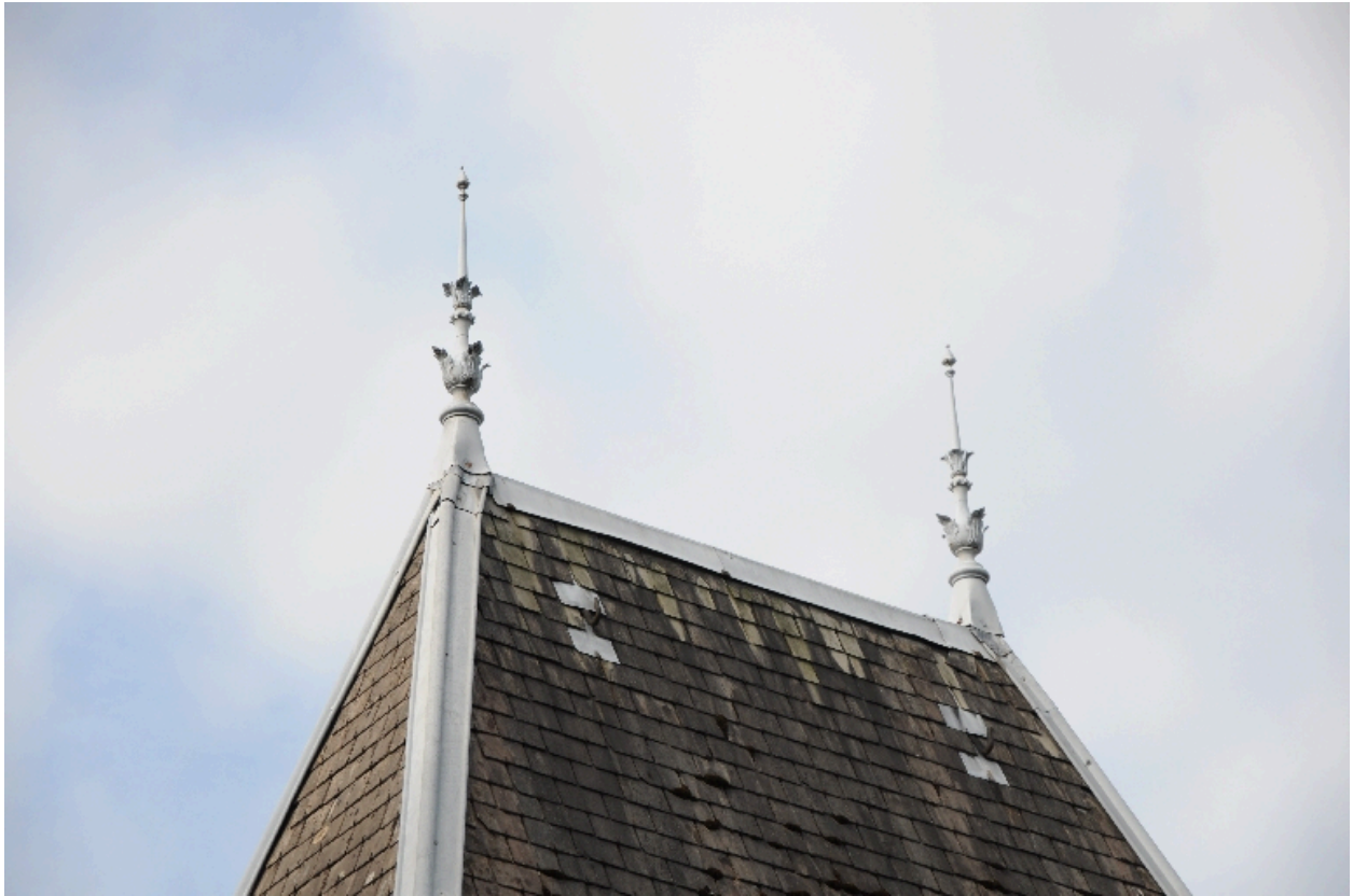
Détail sur les épis de faîtage de la tourelle
