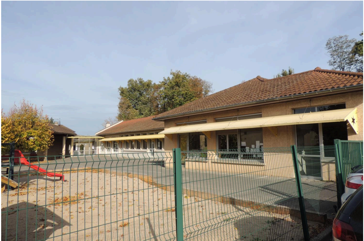
Vue prise depuis la cour, montrant les bâtiments d'origine à droite.
