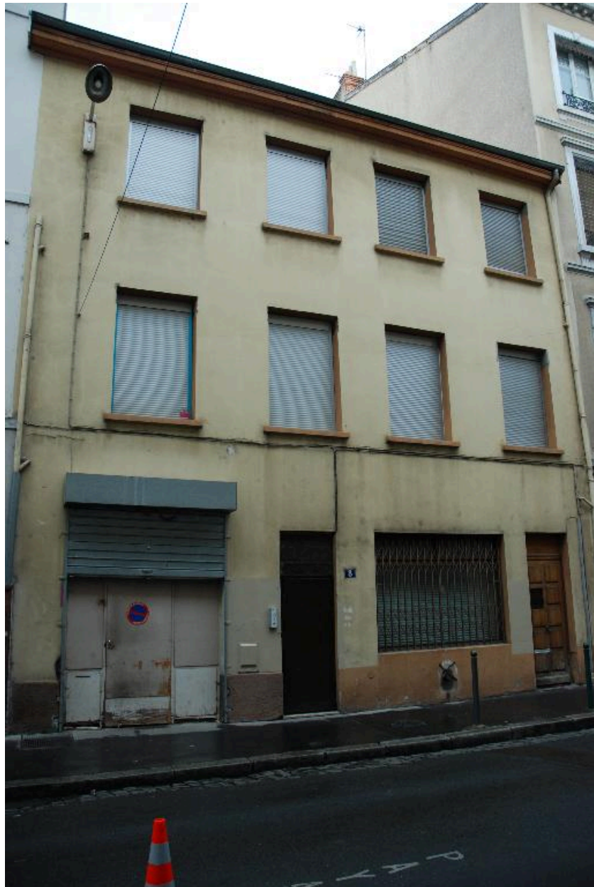
Elévation sur rue, vue générale
