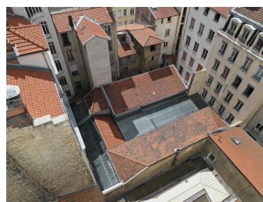
Vue de situation, depuis l'arrière Phot. Eric Dessert IVR82_20126901700NUCA
