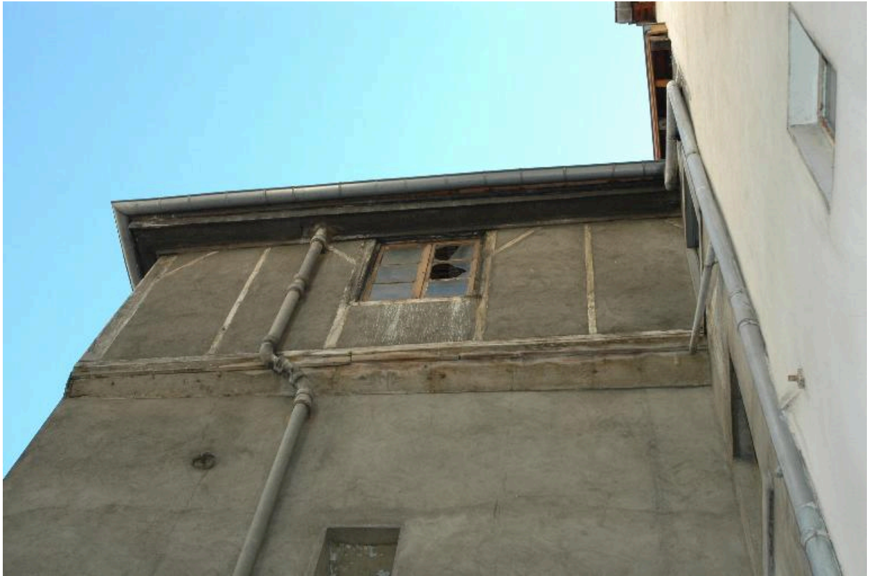
Bâtiment en retour, surélévation en pan-de-bois
