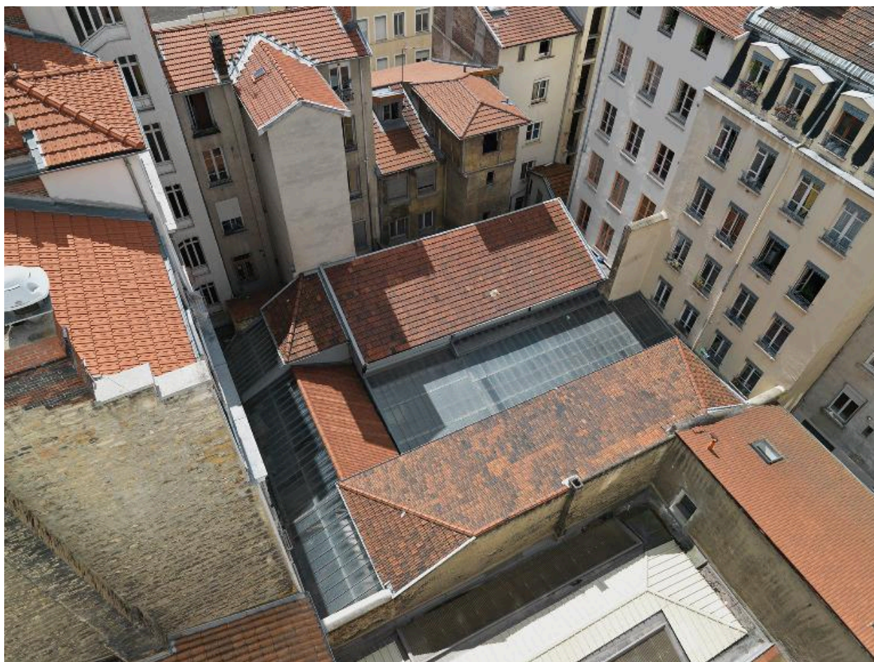
Vue de situation, depuis l'arrière
