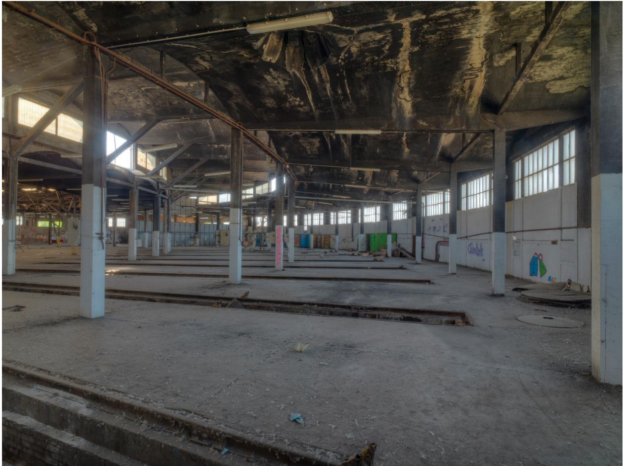
Vue d'ensemble latéral des fosses de réparation
