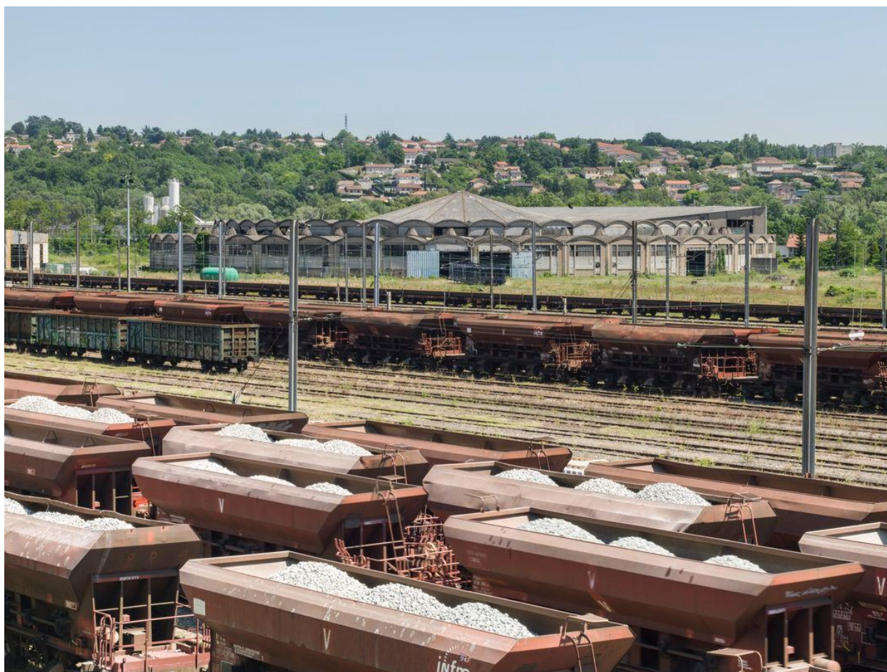
Vue d'ensemble de la rotonde de Grigny
