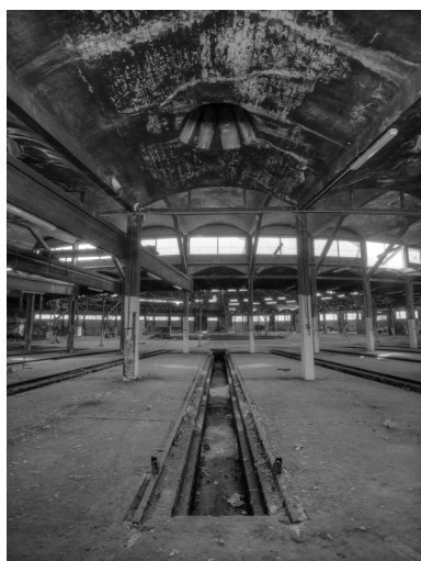
Fosse de réparation de la rotonde Phot. Martial Couderette IVR82_20156901712NUCQ
