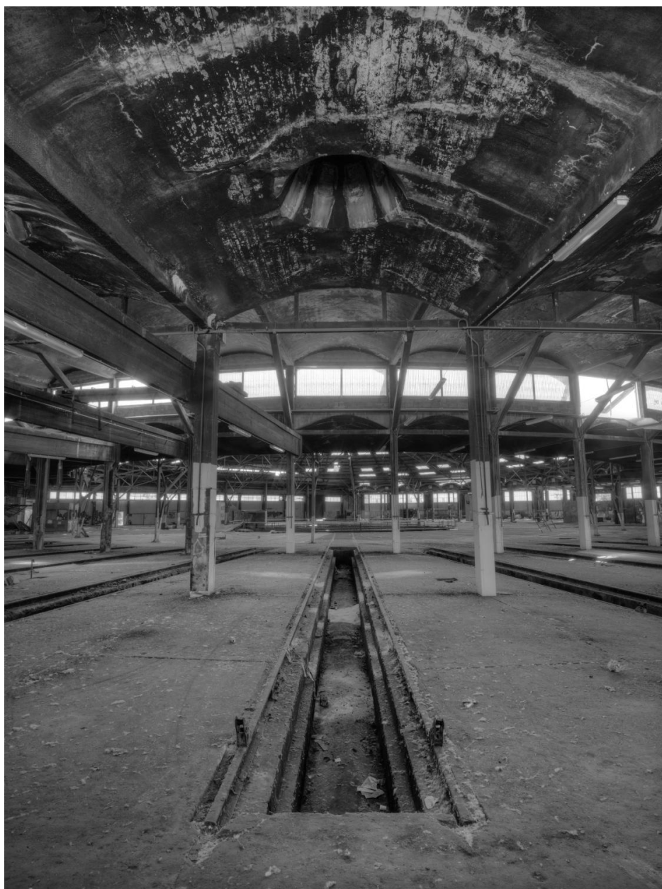
Fosse de réparation de la rotonde
