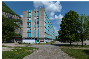
Internat, vue d'ensemble depuis le sud Phot. Eric Dessert IVR84_20163800110NUCA
