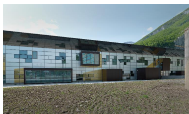
Nouveau bâtiment, élévation sur cour Phot. Eric Dessert IVR84_20163800108NUCA
