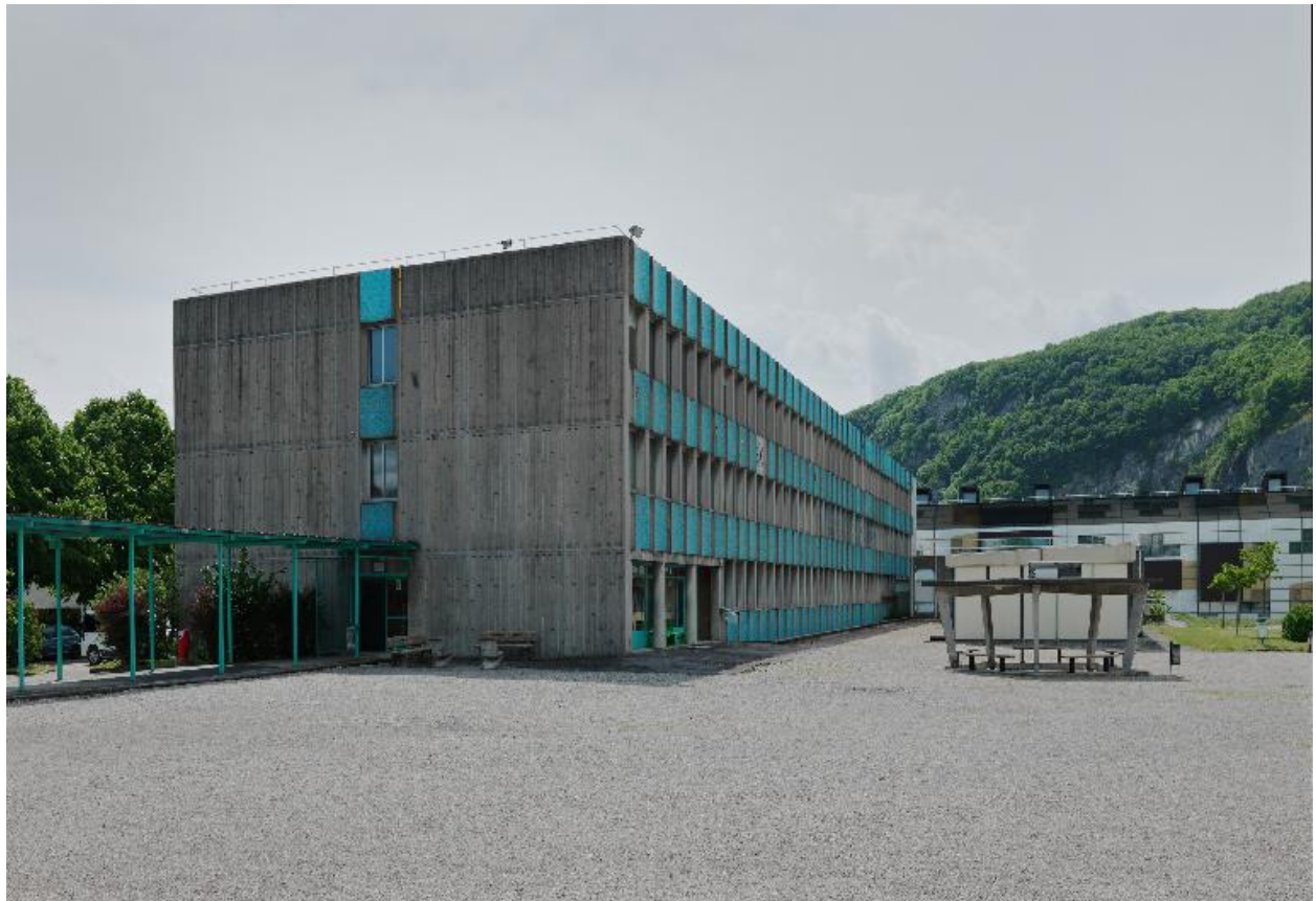
Externat, vue d'ensemble depuis le nord
