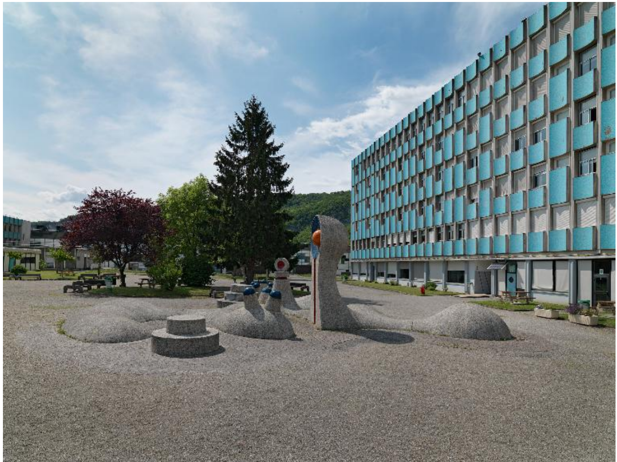
Internat, vue partielle depuis le nord
