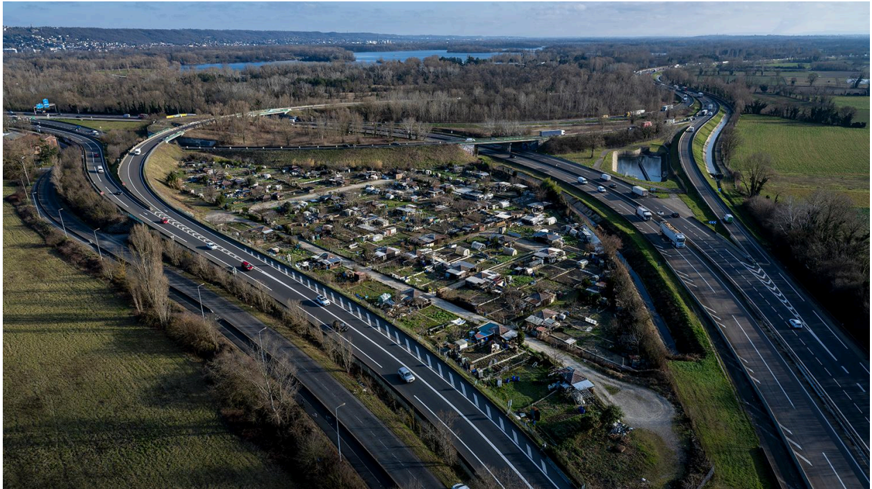
Jardins ouvriers des Reculées entourés par l'A42, vue drone
