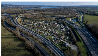
Jardins ouvriers des Reculées entourés par l'A42, vue drone Phot. Michel Pérès IVR84_20256900001NUCA
