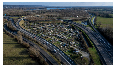
Jardins ouvriers les Reculées entourés par l'A42, Vaulx-en-Velin Phot. Michel Pérès IVR84_20256900002NUCA
