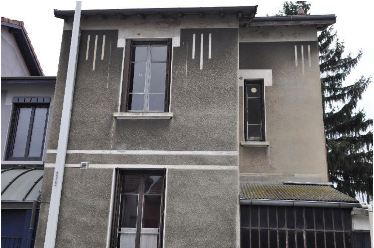
Vue rapprochée de la façade sur rue
