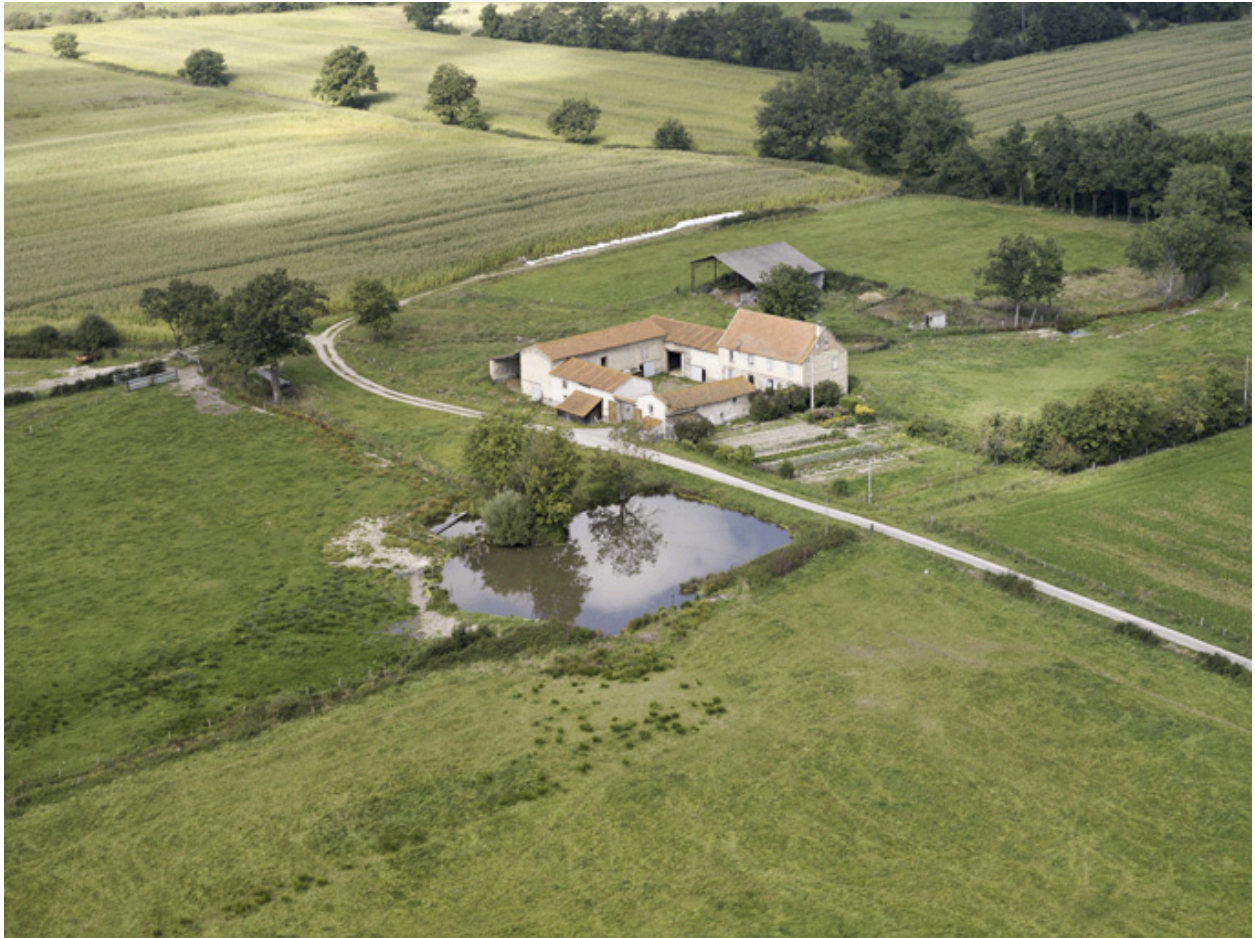
Vue générale aérienne depuis l'est.
