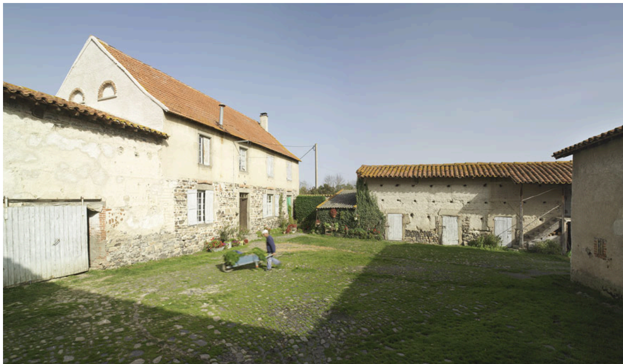
Vue d'ensemble intérieure de la cour, depuis le sud-ouest.
