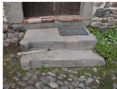
Détail des marches d'escalier en vis remployées devant le seuil de la porte du logis. Phot. Caroline Guibaud IVR82_20114201572NUCA
