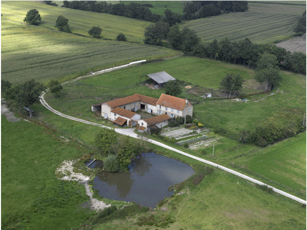
Vue générale aérienne depuis l'est.
