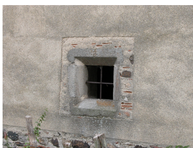
Détail d'une fenêtre à encadrement chanfreiné, en remploi sur la façade nord du logis (jour de la cave). Phot. Caroline Guibaud IVR82_20114201573NUCA
