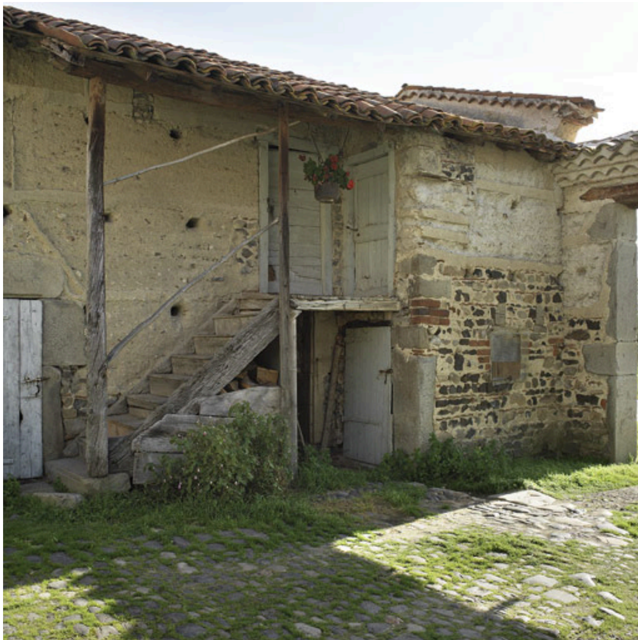
Vue de l'escalier desservant le logement et le grenier du corps de logis nord-est.
