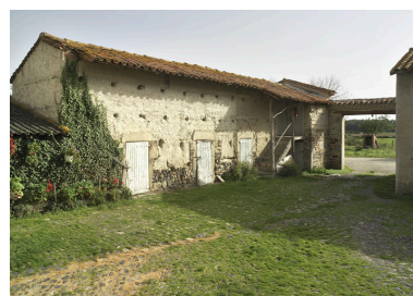
Vue d'ensemble du corps de bâtiment nord-est (porcherie, logement, grenier), depuis l'ouest. Phot. Didier Gourbin IVR82_20064201190NUCA
