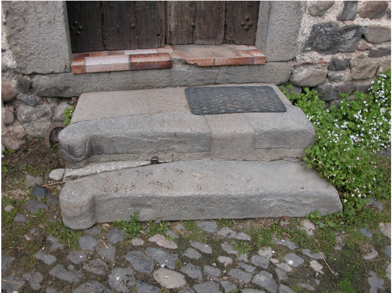
Détail des marches d'escalier en vis remployées devant le seuil de la porte du logis.
