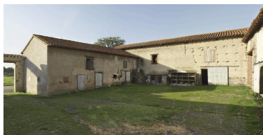
Vue intérieure de la cour depuis le nord : grange-étable, écurie, cave, porcherie et grenier-fenil. Phot. Didier Gourbin IVR82_20064201170NUCAQ
