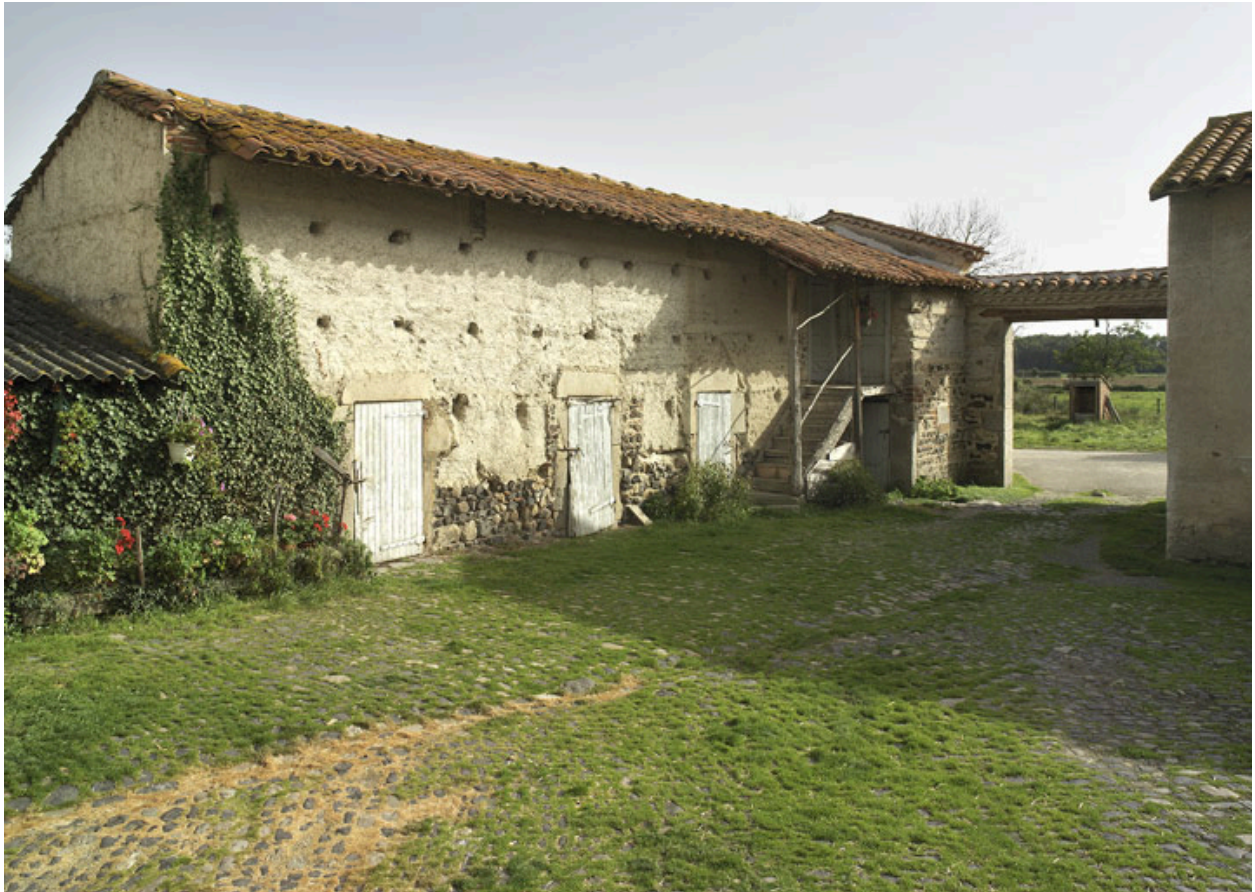
Vue d'ensemble du corps de bâtiment nord-est (porcherie, logement, grenier), depuis l'ouest.
