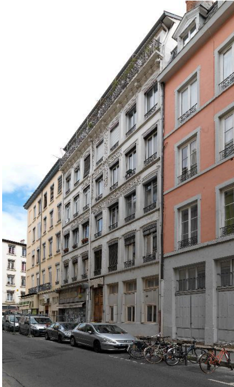
Vue générale de l'élévation sur rue
