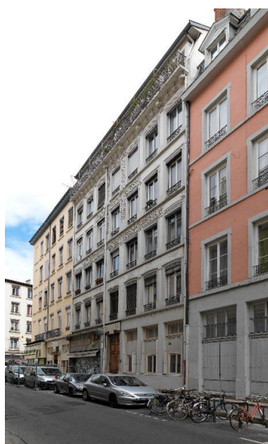
Vue générale de l'élévation sur rue Phot. Eric Dessert IVR84_20166901413NUCA
