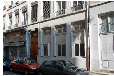
Elévation sur rue, vue rapprochée du rez-de-chaussée Phot. Catherine Guégan IVR84_20166900538NUCA
