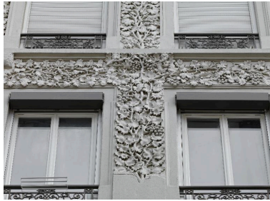
Elévation sur rue, détail du décor sculpté Phot. Eric Dessert IVR84_20166901415NUCA
