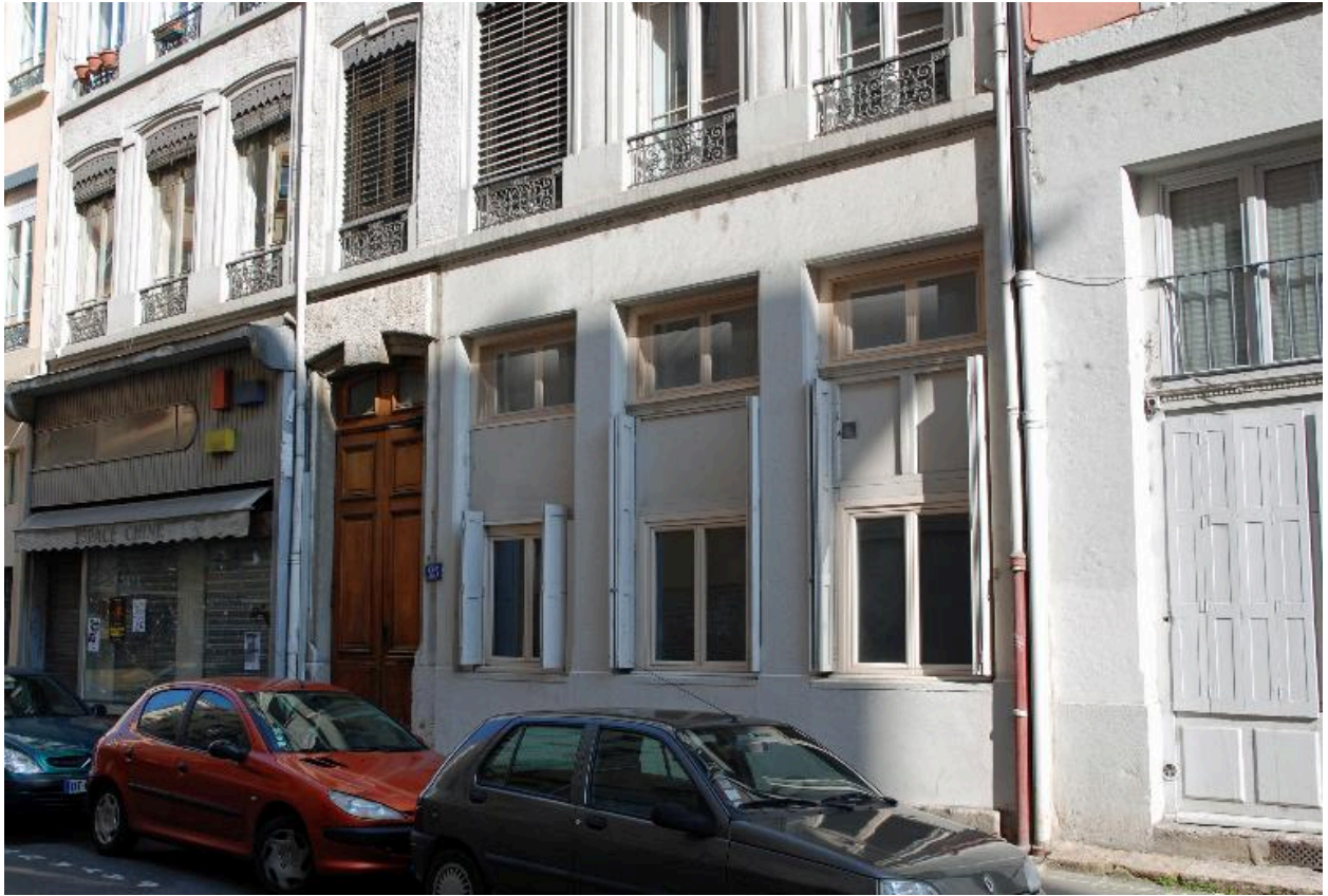
Elévation sur rue, vue rapprochée du rez-de-chaussée
