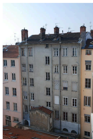
Vue générale de l'élévation postérieure Phot. Catherine Guégan IVR84_20166900537NUCA
