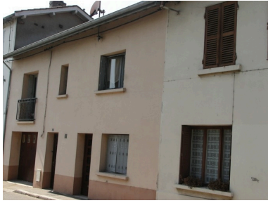
façade sud ouest Phot. Benoît Chapelle IVR82_20073800059NUCA
