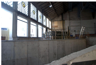
Vue intérieure en cours de travaux (janvier 2008) Phot. Maryannick Chalabi IVR82_20136900970NUCA
