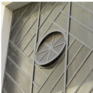
Détail de la porte principale Phot. Eric Dessert IVR82_20076902434NUCA
