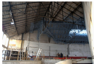
La charpente métallique Phot. Maryannick Chalabi IVR82_20136900969NUCA
