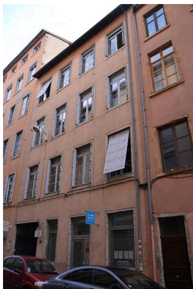
Vue générale façade ouest Phot. Noémie Caillat IVR82_20156900123NUCA
