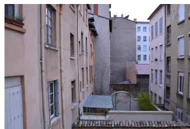
Atelier sur cour Phot. Noémie Caillat IVR82_20156900063NUCA
