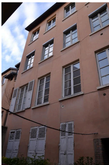
vue d'ensemble façade est Phot. Noémie Caillat IVR82_20156900125NUCA
