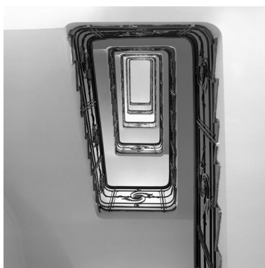
Vue de l'escalier en contre-plongée Phot. Eric Dessert IVR82_20016902728X
