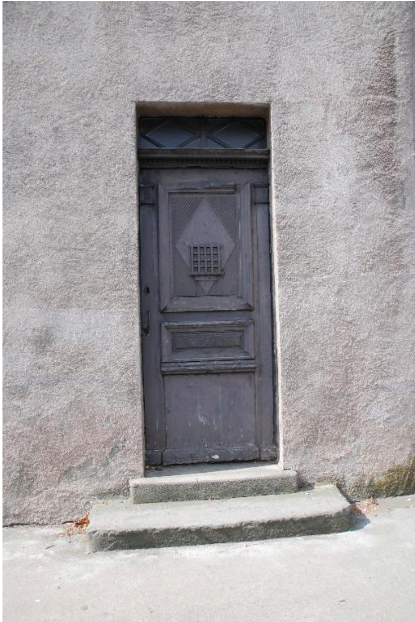
Vue sur de la porte de l'ancienne loge de gardien (aile nord, côté rue du Faubourg de la Croix).
