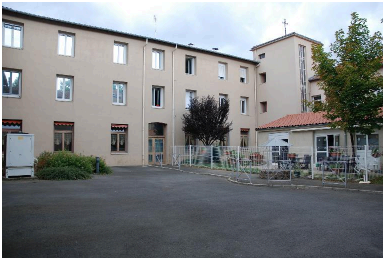
Vue sur l'aile ouest de la cour (ancien cloître).
