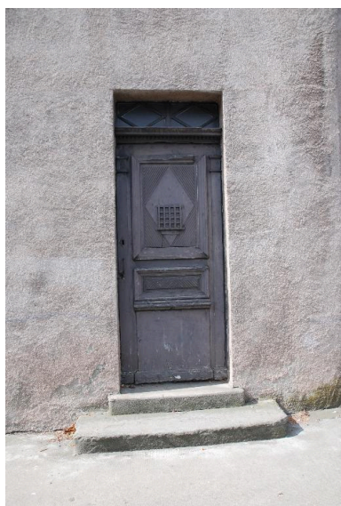
Vue sur de la porte de l'ancienne loge de gardien (aile nord, côté rue du Faubourg de la Croix). Phot. Caroline Guibaud IVR82_20154200344NUCA
