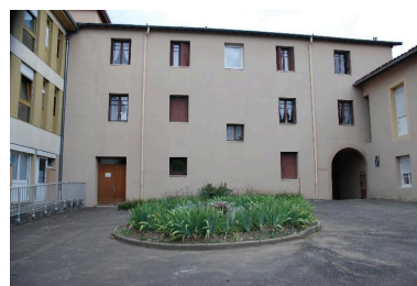
Vue sur l'aile sud (côté extérieur). Phot. Caroline Guibaud IVR82_20154200335NUCA
