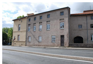
Vue d'une partie de l'aile nord depuis la rue de Beauregard. Phot. Caroline Guibaud IVR82_20154200343NUCA
