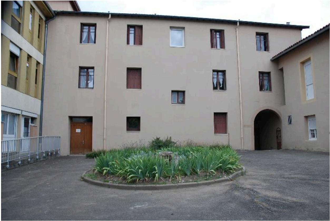
Vue sur l'aile sud (côté extérieur).
