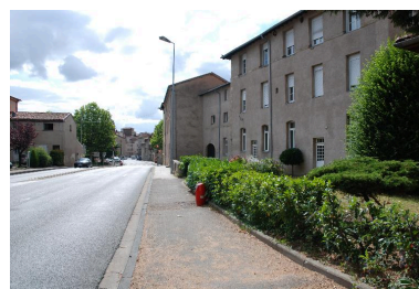
Vue sur l'aile nord depuis la rue Beauregard. Phot. Caroline Guibaud IVR82_20154200341NUCA
