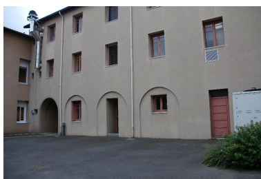
Vue sur l'aile sud depuis la cour (ancien cloître du couvent). Phot. Caroline Guibaud IVR82_20154200334NUCA
