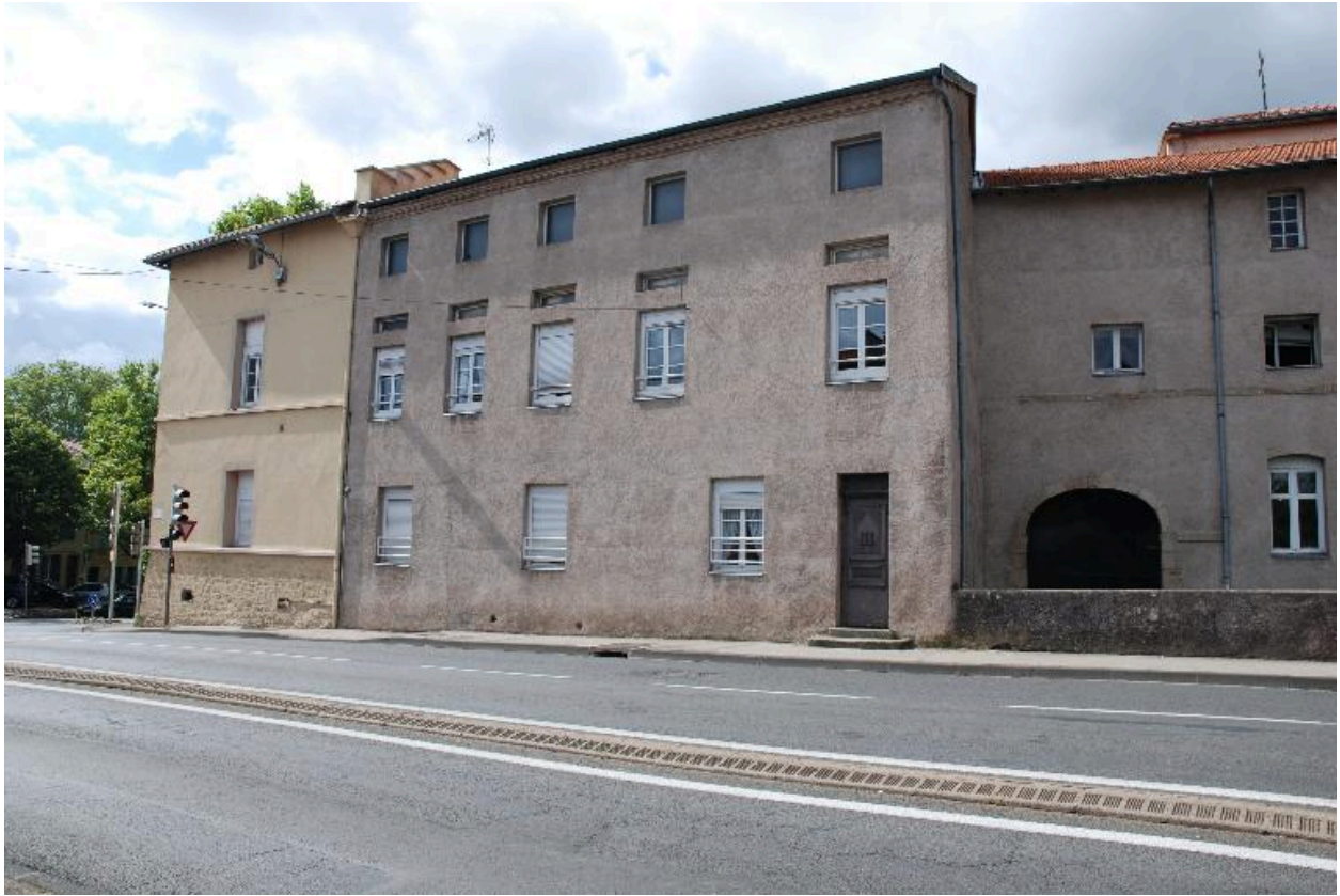
Vue d'une partie de l'aile nord depuis la rue de Beauregard.
