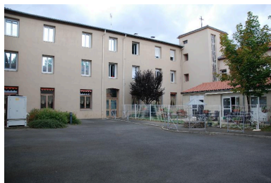
Vue sur l'aile ouest de la cour (ancien cloître). Phot. Caroline Guibaud IVR82_20154200336NUCA
