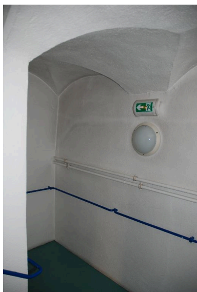
Vue de l'escalier de l'aile est : palier voûté. Phot. Caroline Guibaud IVR82_20154200339NUCA
