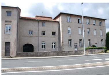
Vue d'une partie de l'aile nord depuis la rue de Beauregard. Phot. Caroline Guibaud IVR82_20154200342NUCA
