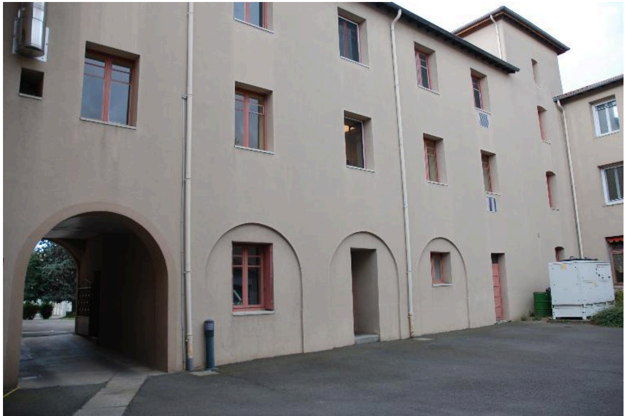
Vue sur l'aile sud depuis la cour (ancien cloître).
