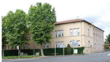
Vue de l'angle nord-est depuis la place de la préfecture. Phot. Caroline Guibaud IVR82_20154200346NUCA
