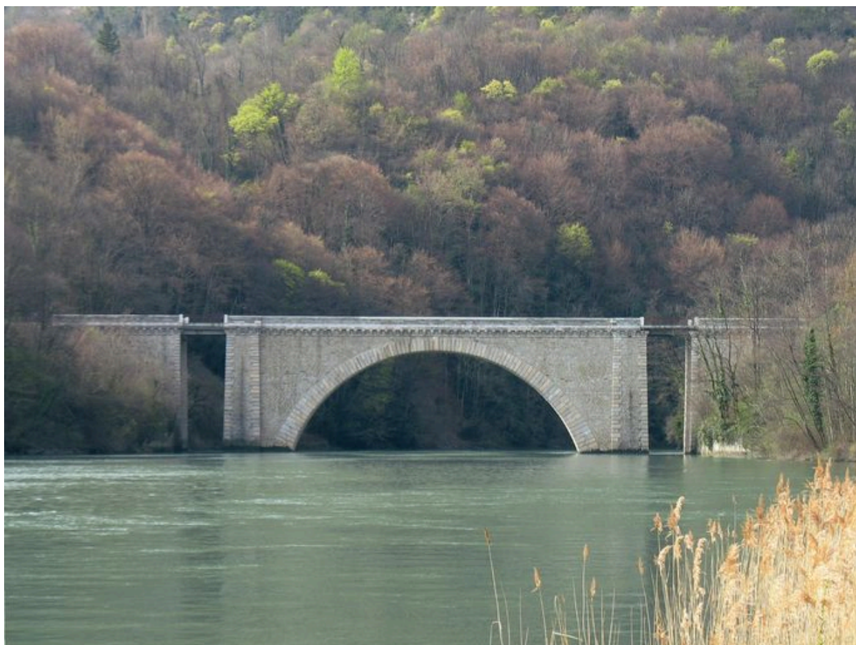
Vue panoramique (face amont)
