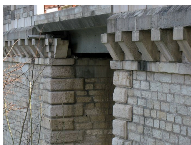
Vue partielle d'une coupure (face amont, côté droit) Phot. I. Havard IVR82_20090100010NUCA
