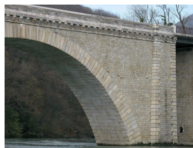
Arche centrale, vue partielle, face amont, côté droit Phot. I. Havard IVR82_20090100006NUCA
