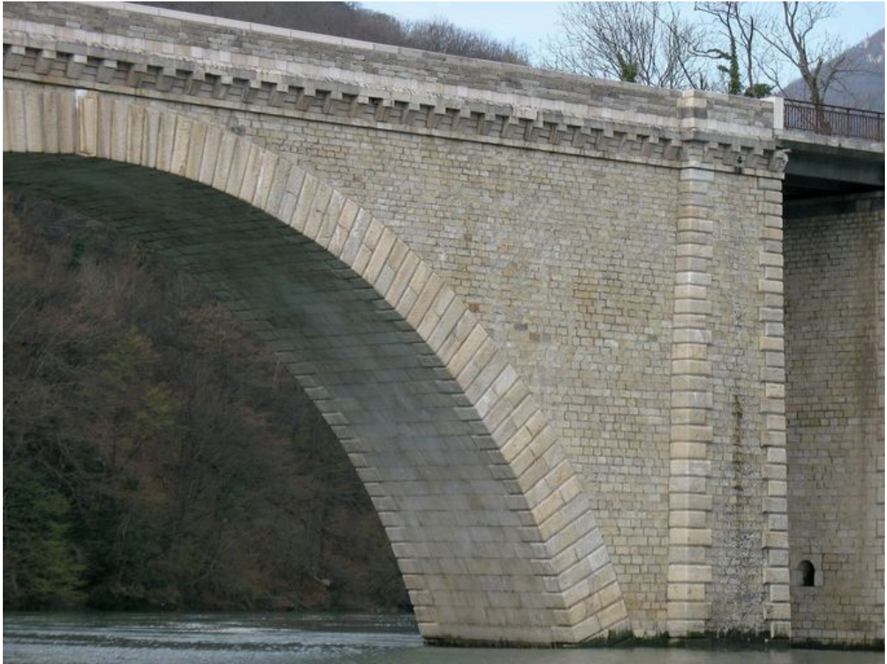
Arche centrale, vue partielle, face amont, côté droit
