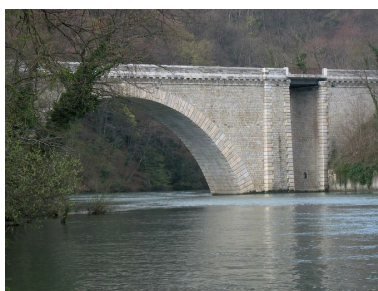
Vue partielle de l'arche, face amont, côté droit (depuis la rive gauche) Phot. I. Havard IVR82_20090100005NUCA
