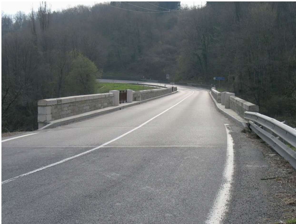
Vue sur le tablier
