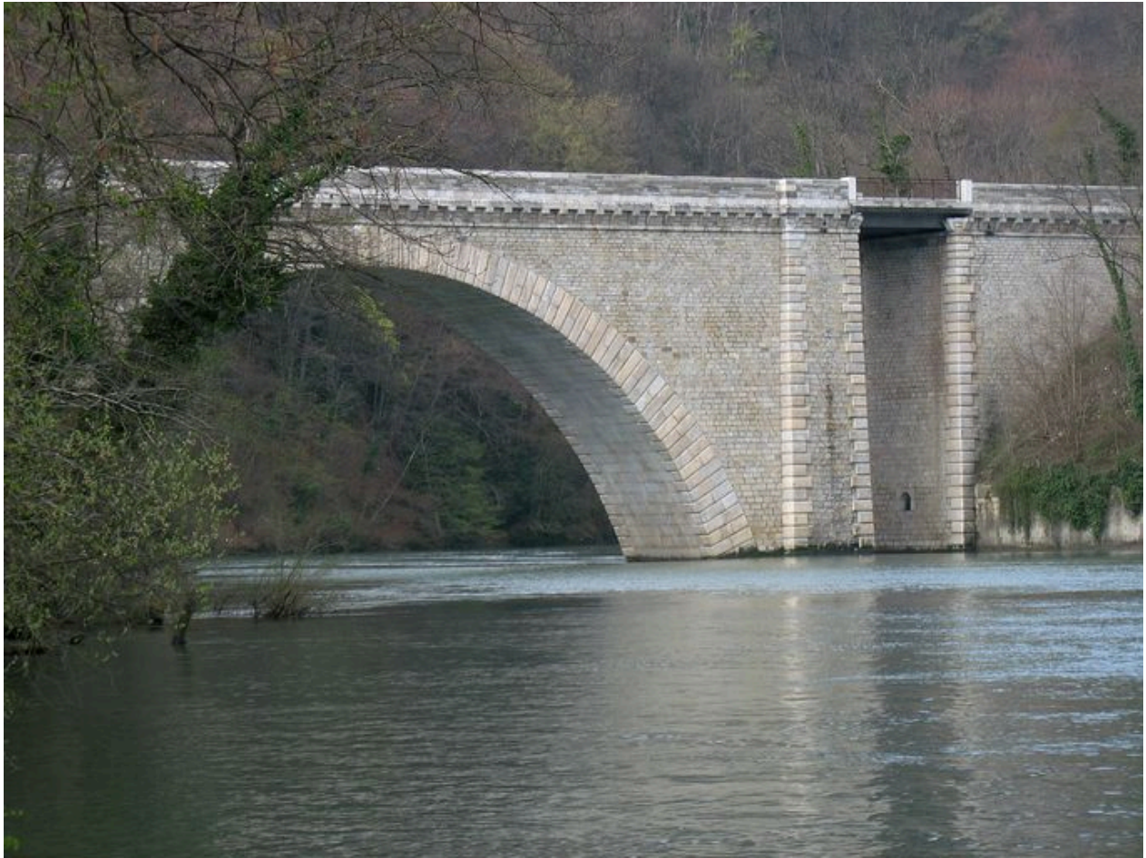
Vue partielle de l'arche, face amont, côté droit (depuis la rive gauche)
