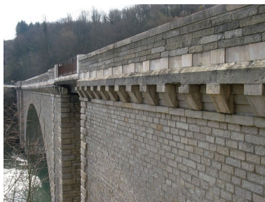
Vue de la face amont, depuis le haut de la rive droite Phot. I. Havard IVR82_20090100008NUCA
