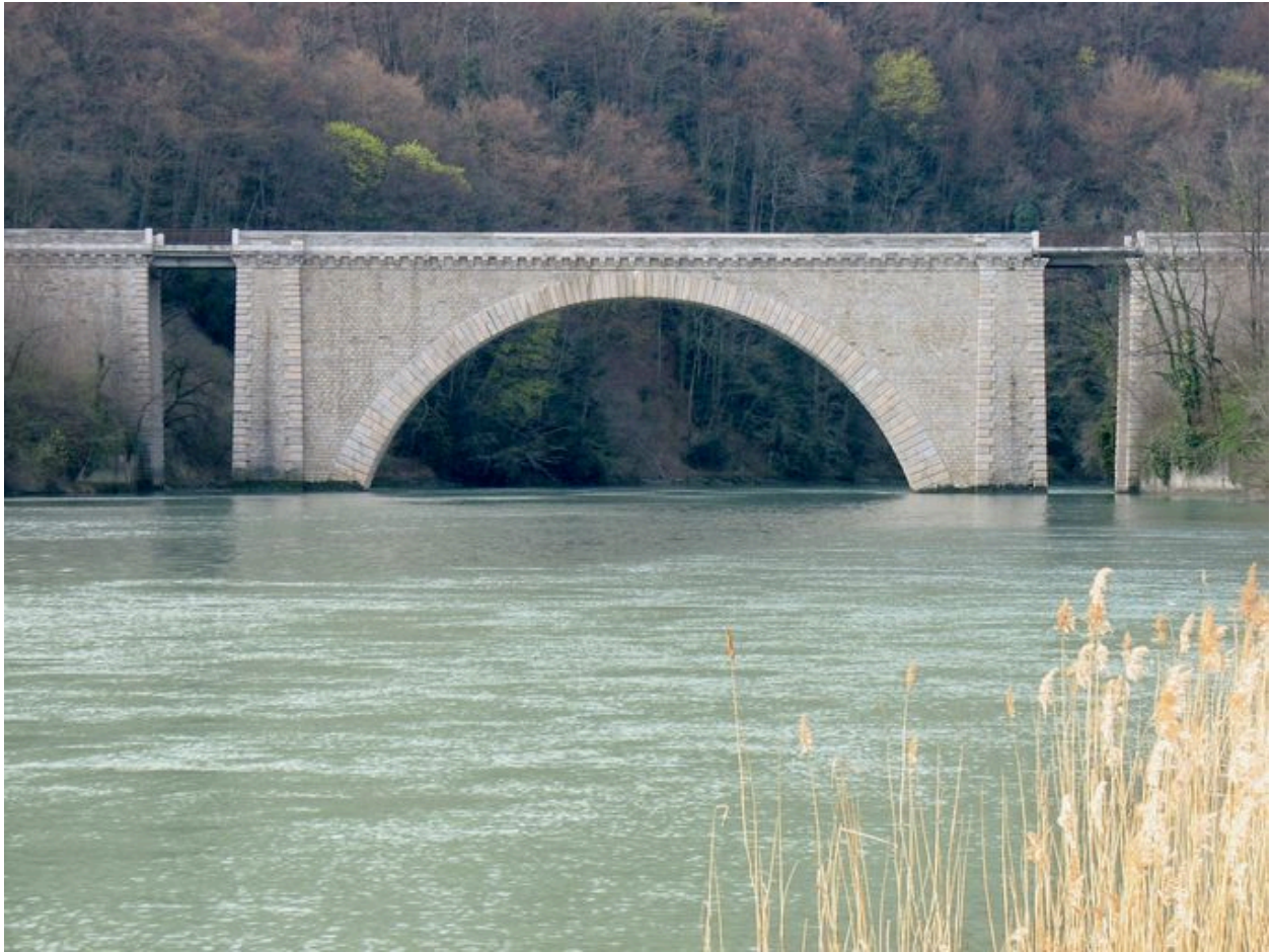
Vue générale, côté amont
