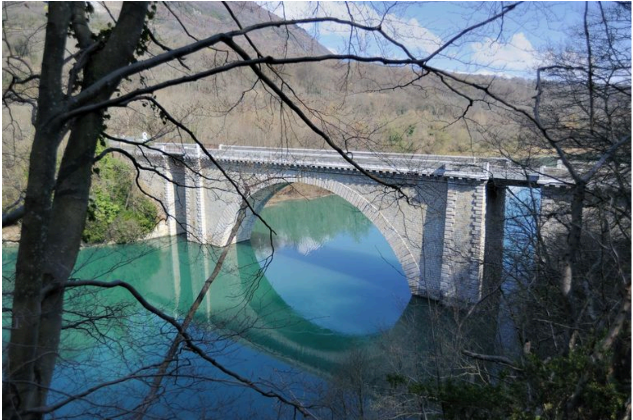
Vue générale, côté amont
