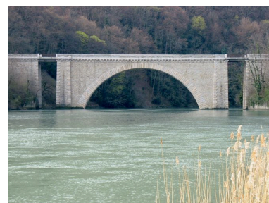
Vue générale, côté amont Phot. I. Havard IVR82_20090100001NUCA
