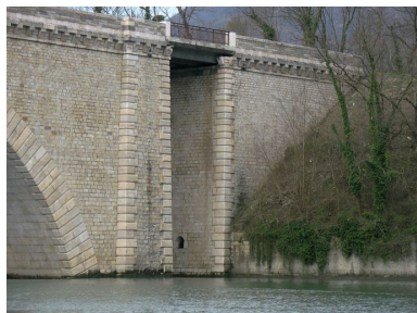
Vue de la culée et coupure rive droite, face amont Phot. I. Havard IVR82_20090100007NUCA
