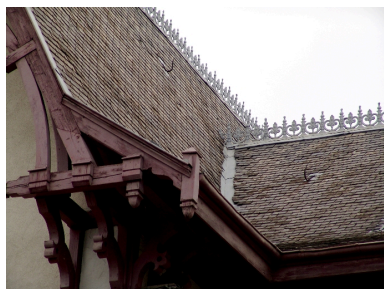
Détail de l'avant-toit Phot. François Fouger IVR82_20077300317NUCA
