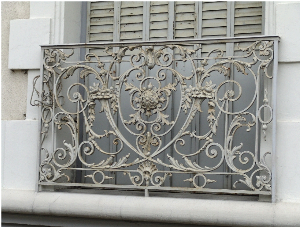
Détail d'un garde-corps
