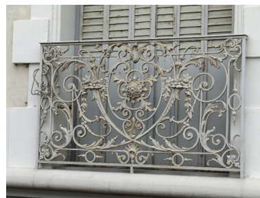
Détail d'un garde-corps Phot. François Fouger IVR82_20077300314NUCA
