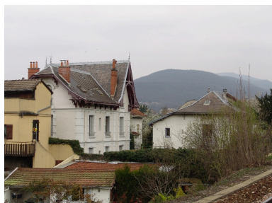
Vue d'ensemble depuis l'arrière Phot. François Fouger IVR82_20077300323NUCA
