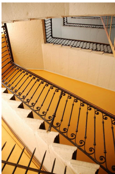
Immeuble sud : escalier, vue en contre-plongée Phot. Catherine Guégan IVR82_20156900903NUCA
