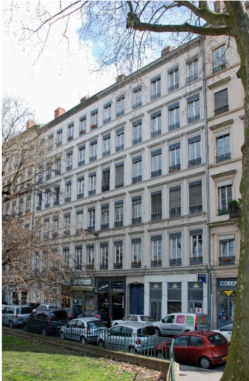
Vue d'ensemble des deux immeubles, depuis le sud-ouest
