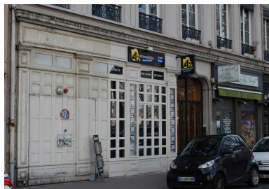
Immeuble nord, vue du rez-de-chaussée et des boutiques Phot. Catherine Guégan IVR82_20156900901NUCA
