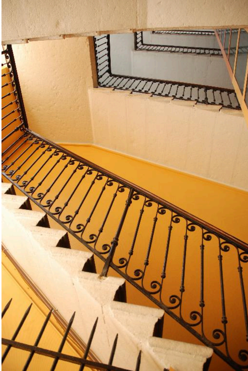
Immeuble sud : escalier, vue en contre-plongée
