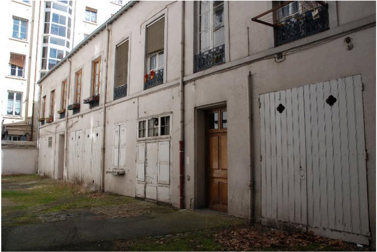
Vue du bâtiment sur cour, depuis le sud
