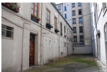
Vue du bâtiment sur cour, depuis le nord Phot. Catherine Guégan IVR82_20156900904NUCA
