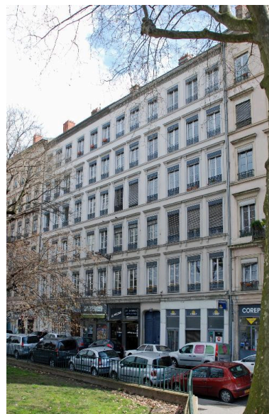
Vue d'ensemble des deux immeubles, depuis le sud-ouest Phot. Catherine Guégan IVR82_20156900897NUCA
