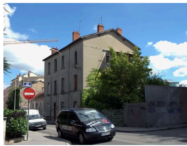
Vue d'ensemble depuis le sud Phot. Catherine Guégan IVR82_20086901432NUCA
