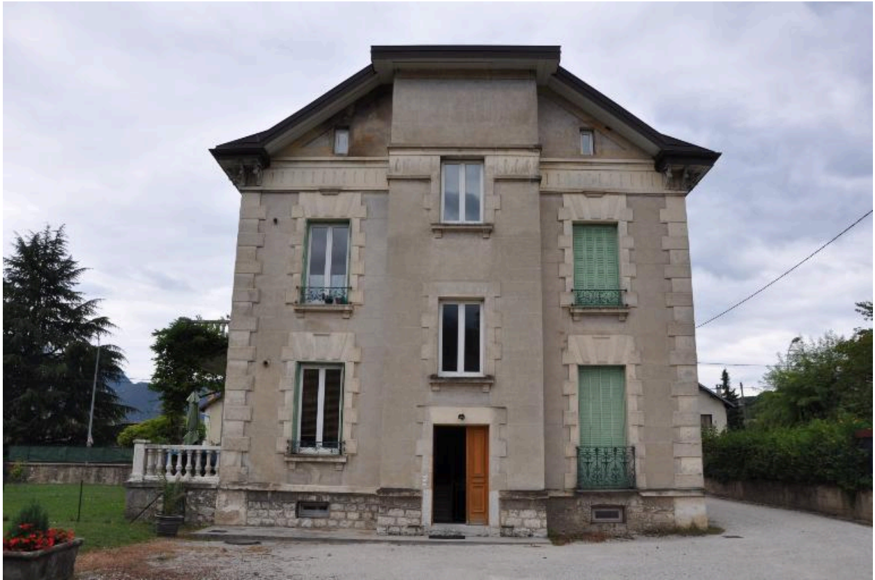
Façade latérale est
