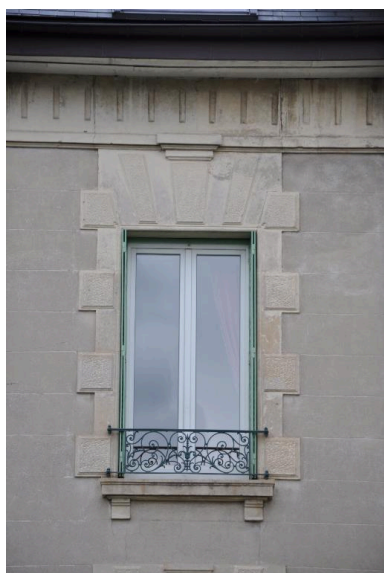
Détail d'une baie Phot. Denys Harreau IVR82_20137300937NUCA
