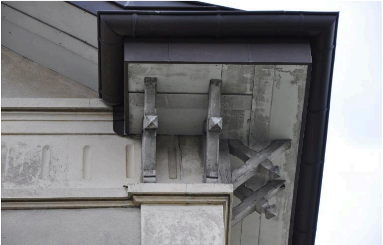
Détail des aisseliers sous l'avant-toit
