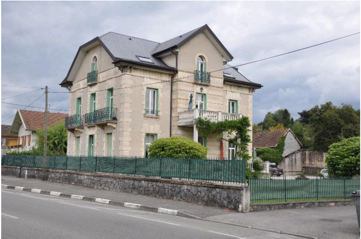
Vue d'ensemble depuis la rue
