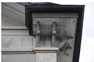
Détail des aisseliers sous l'avant-toit Phot. Denys Harreau IVR82_20137300935NUCA
