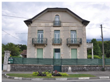
Façade latérale ouest Phot. Denys Harreau IVR82_20137300931NUCA
