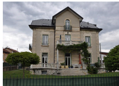
Façade sur jardin Phot. Denys Harreau IVR82_20137300938NUCA
