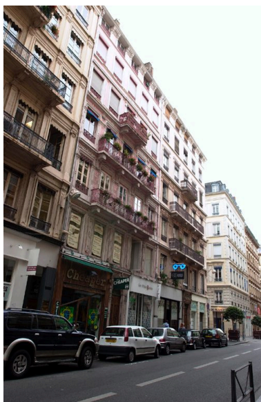
Vue de situation Phot. Bernard Ducouret IVR82_20046905222NUCA
