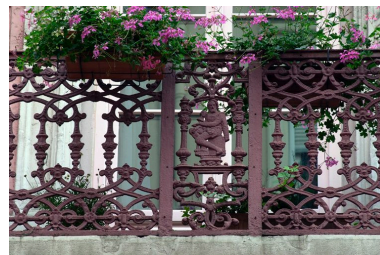
Garde-corps du balcon, deuxième étage carré : panneau central orné d'un sculpteur Phot. Bernard Ducouret IVR82_20046905230NUCA
