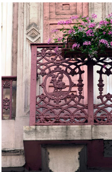
Garde-corps des balcons des deuxième et troisième étages carrés : panneau latéral orné d'un couple de danseurs Phot. Bernard Ducouret IVR82_20046905232NUCA
