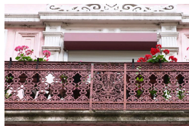
Garde-corps du balcon, quatrième étage carré : détail Phot. Bernard Ducouret IVR82_20046905233NUCA
