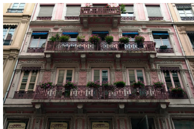
Vue des étages carrés ornés de balcons, état en 2004 Phot. Bernard Ducouret IVR82_20046905228NUCA
