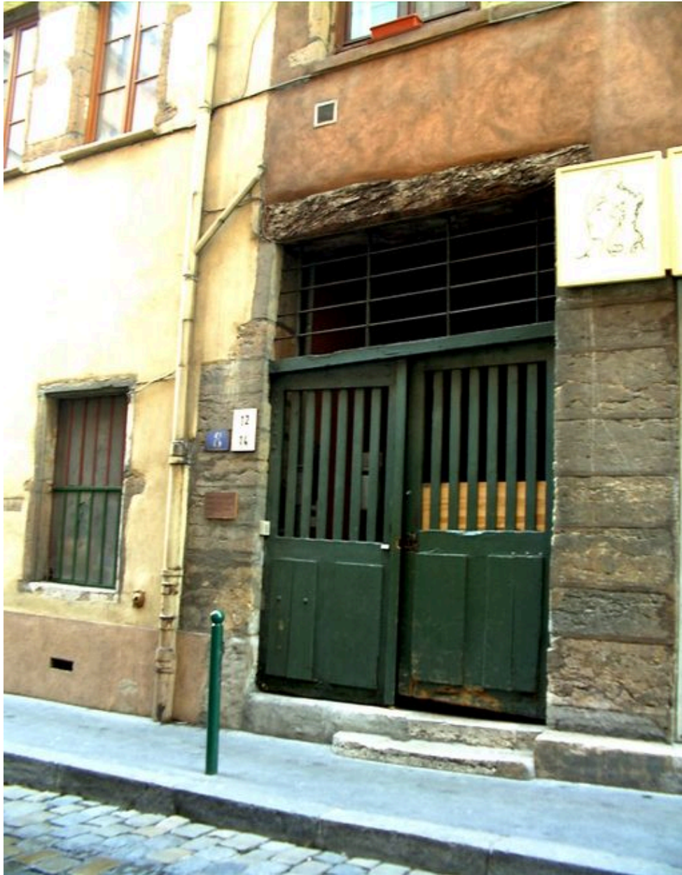
Porte d'entrée rue du Doyenné
