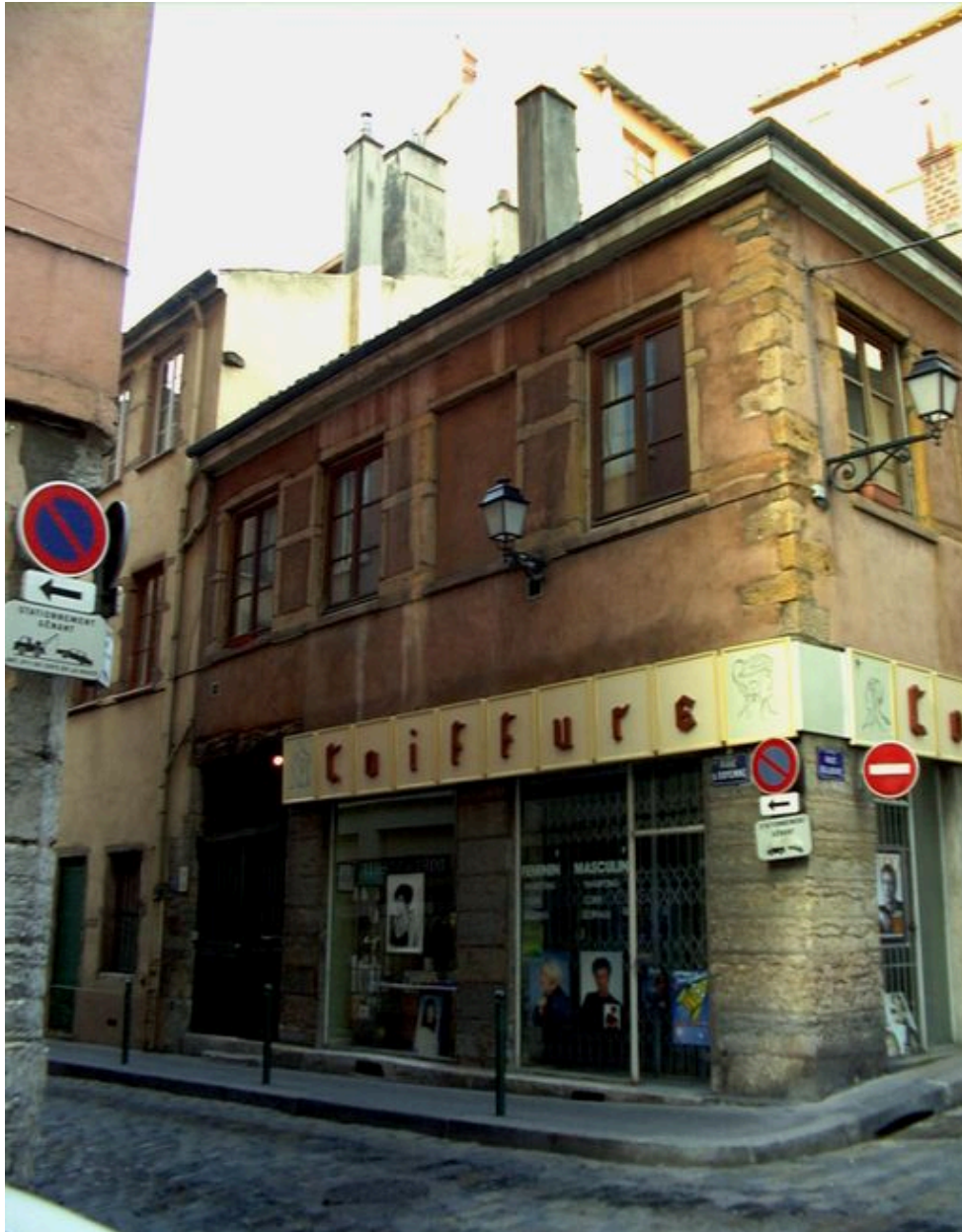
Elévation, rue du Doyenné
