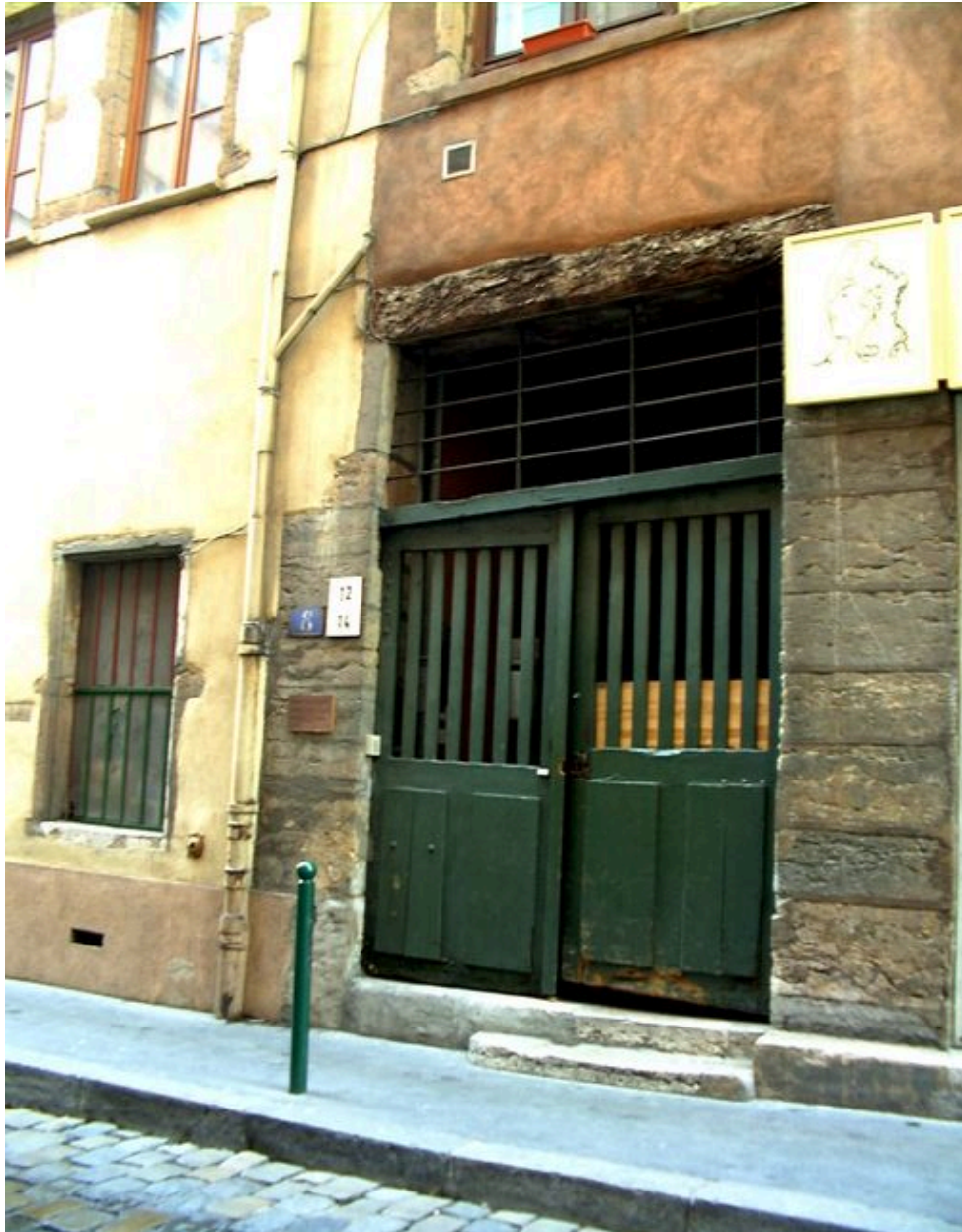
Porte d'entrée rue du Doyenné
