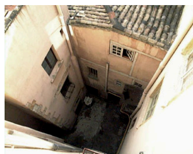
Vue de la cour commune aux 12 rue du Doyenné, 5 et 7 rue Bellière, et 10 rue Ferrachat Phot. Maryannick Chalabi IVR82_20006900183NUCA
