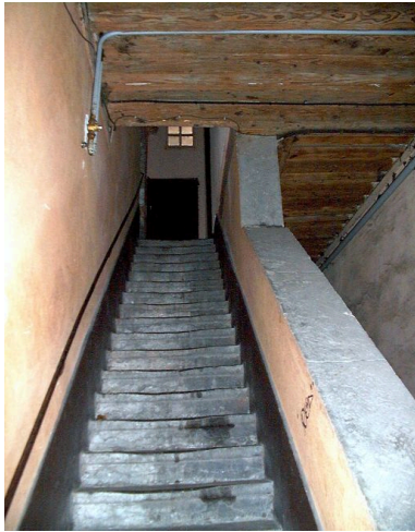
Escalier commun aux 12 et 14 rue du Doyenné Phot. Maryannick Chalabi IVR82_20006900179NUCA
