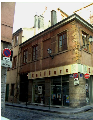
Elévation, rue du Doyenné Phot. Maryannick Chalabi IVR82_20006900155NUCA
