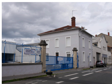
Vue d'ensemble de l'usine Limousin et Descours Phot. Nadine Halitim-Dubois IVR84_20246900115NUCA
