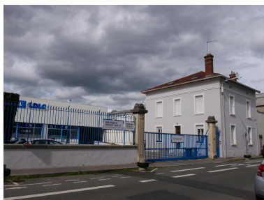
Vue d'ensemble de l'usine Limousin et Descours Phot. Nadine Halitim-Dubois IVR84_20246900114NUCA
