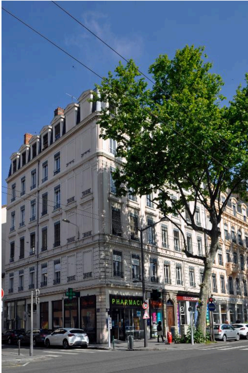
Vue d'ensemble, depuis le sud (élévation sur la rue de la Thibaudière)
