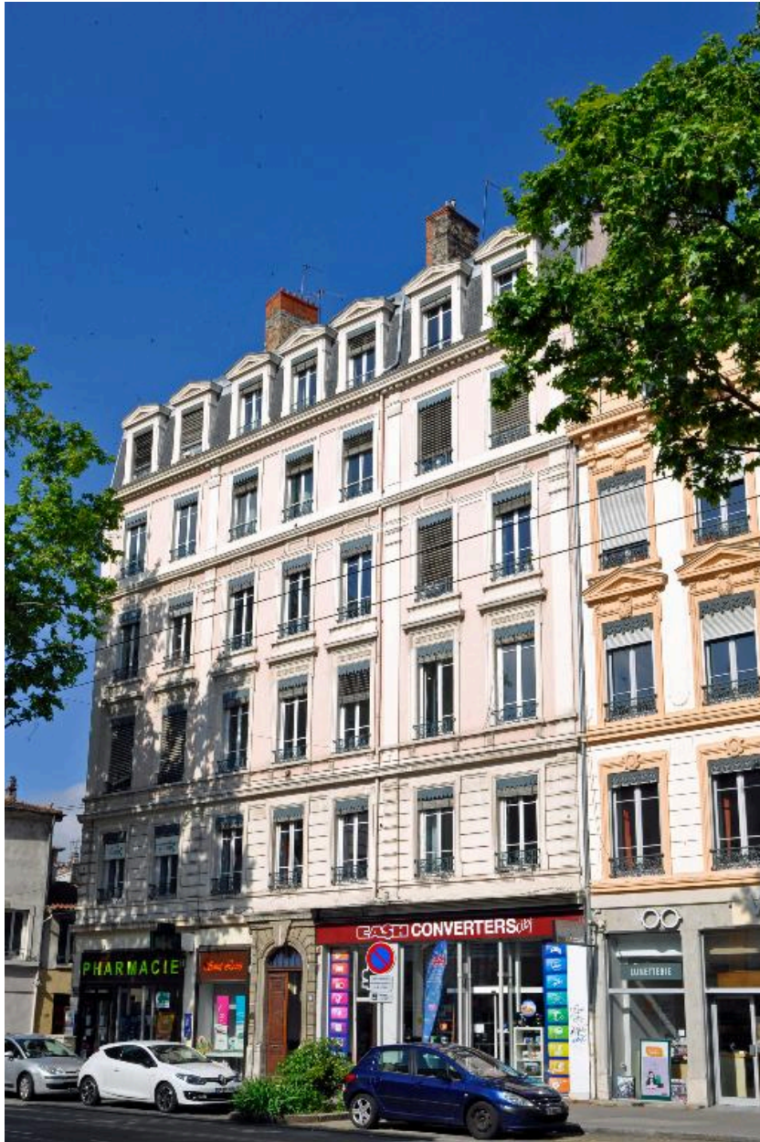
Vue de l'élévation principale, sur l'avenue Jean-Jaurès
