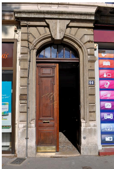
Vue rapprochée de la porte Phot. Catherine Guégan IVR84_20176901413NUCA
