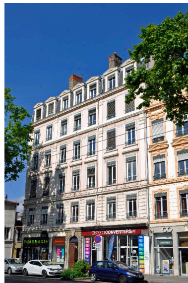
Vue de l'élévation principale, sur l'avenue Jean-Jaurès Phot. Catherine Guégan IVR84_20176901412NUCA
