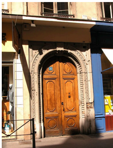
Détail de la porte : vue extérieure Phot. David Chevallier IVR82_20046905121NUCA
