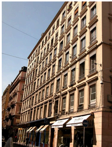
Vue d'ensemble avec les immeubles mitoyens (28 et 30 rue de Brest) Phot. David Chevallier IVR82_20046905119NUCA
