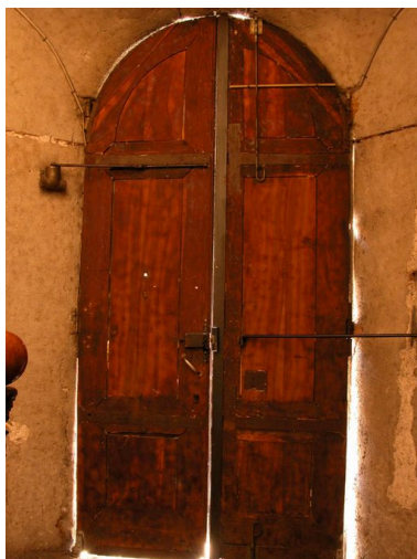
Détail de la porte : vue intérieure Phot. David Chevallier IVR82_20046905122NUCA
