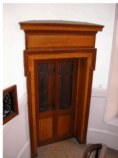
Porte de la loge de concierge donnant sur le premier repos de l'escalier Phot. Maryannick Chalabi IVR82_20046904521NUCA
