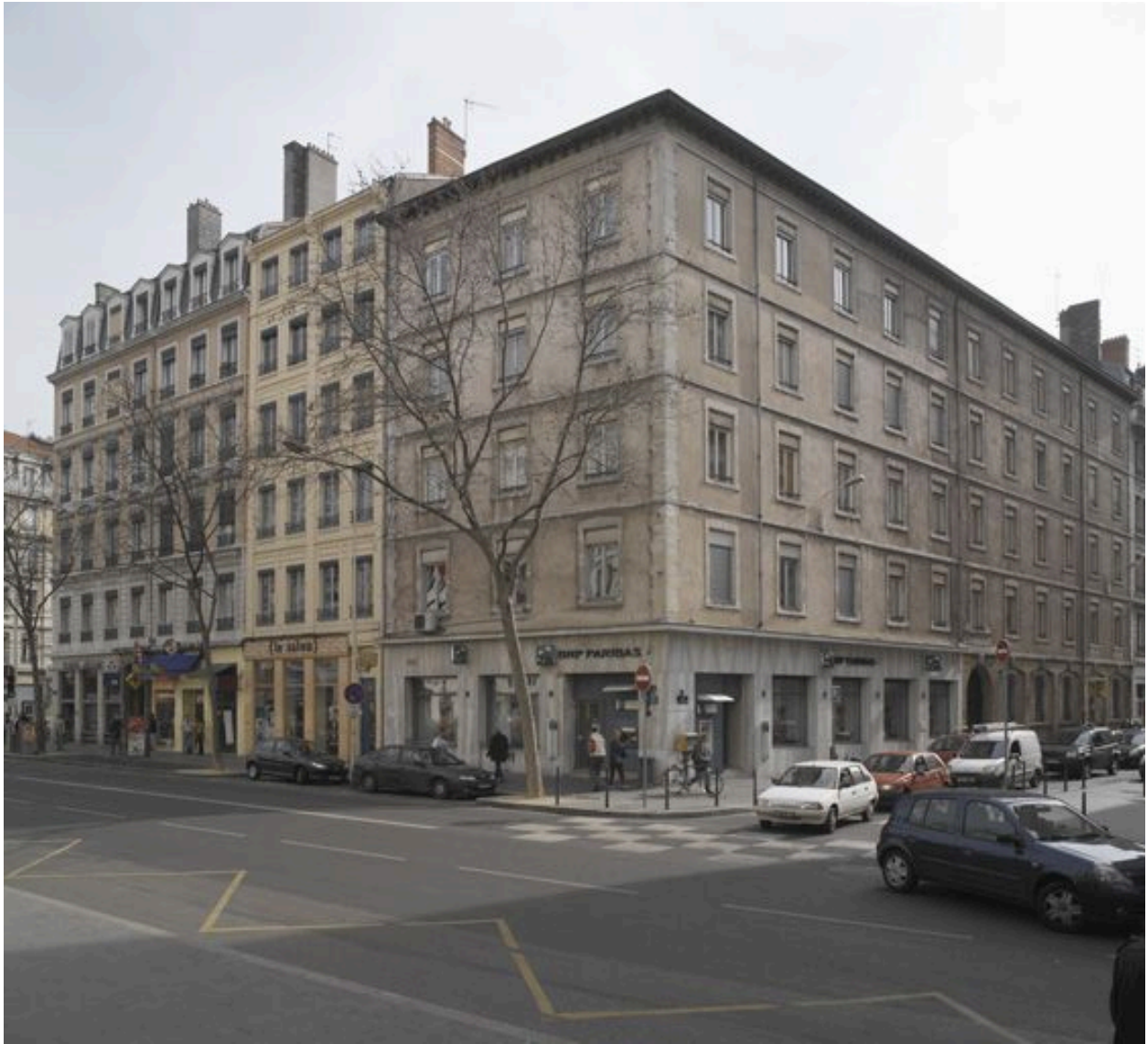
Elévation cours Gambetta, depuis le nord-ouest
