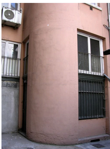
Détail de la façade postérieure du corps de bâtiment avenue Jean-Jaurès Phot. Maryannick Chalabi IVR82_20046904516NUCA
