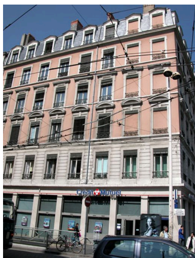
Vue générale de la façade sur l'avenue Jean-Jaurès Phot. Maryannick Chalabi IVR82_20046904507NUCA
