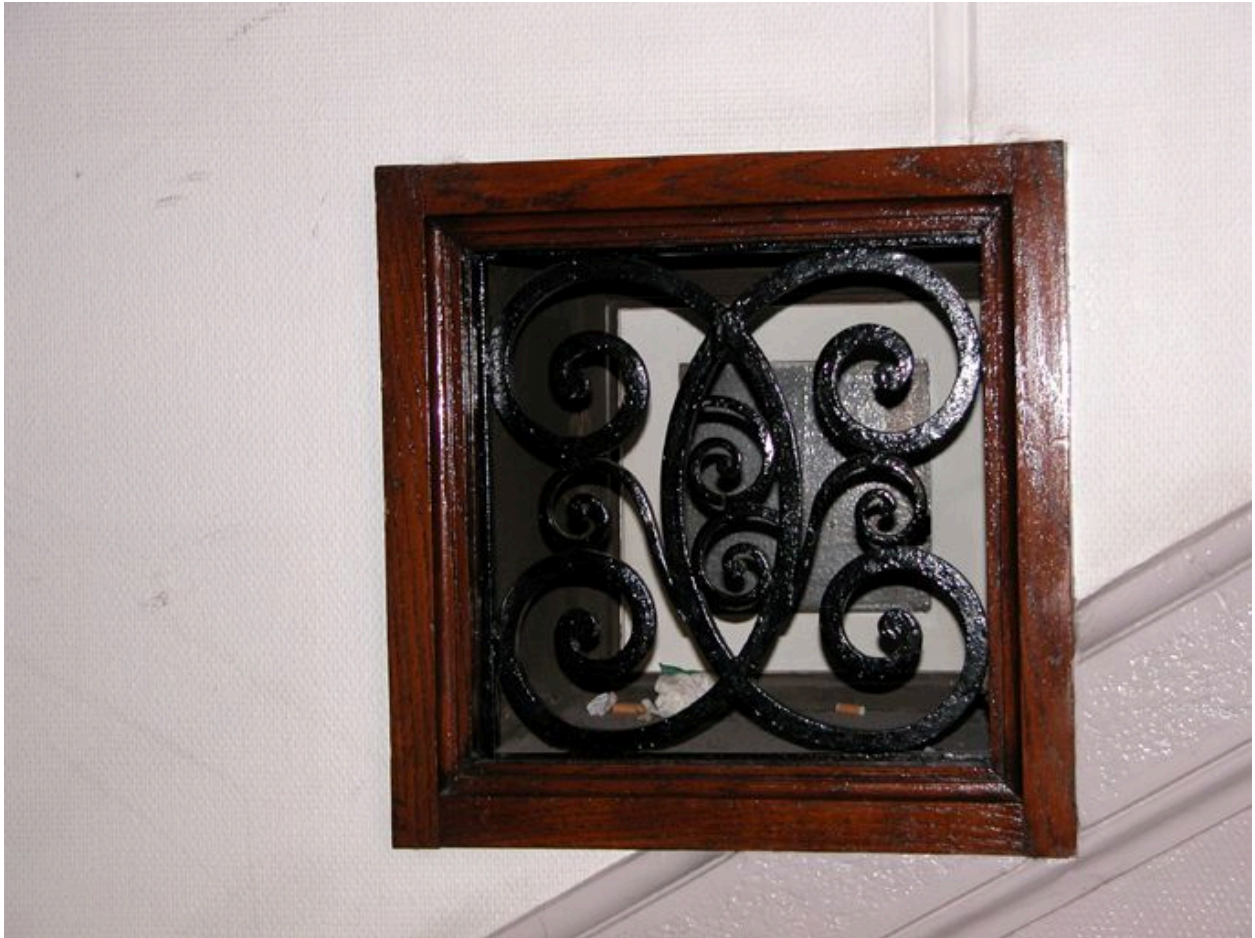
Détail de la grille d'une baie de l'escalier
