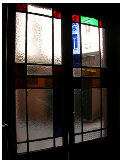
Fenêtre avec vitraux dans la montée d'escalier Phot. Maryannick Chalabi IVR82_20046904513NUCA
