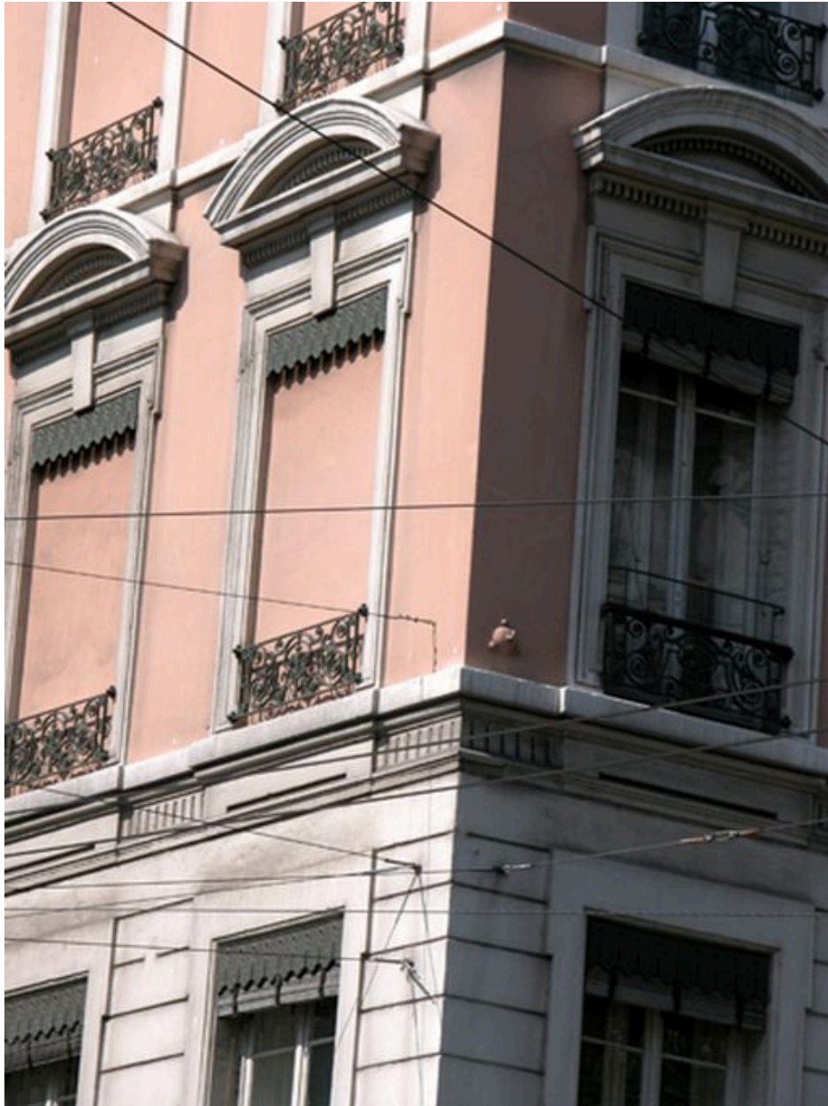
Détail de l'angle des façades cours Gambetta - avenue Jean-Jaurès
