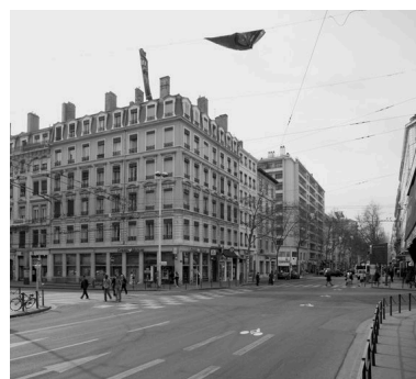
Vue générale des façades sur le cours Gambetta et l'avenue Jean-Jaurès Phot. Eric Dessert IVR82_20056900600NUC
