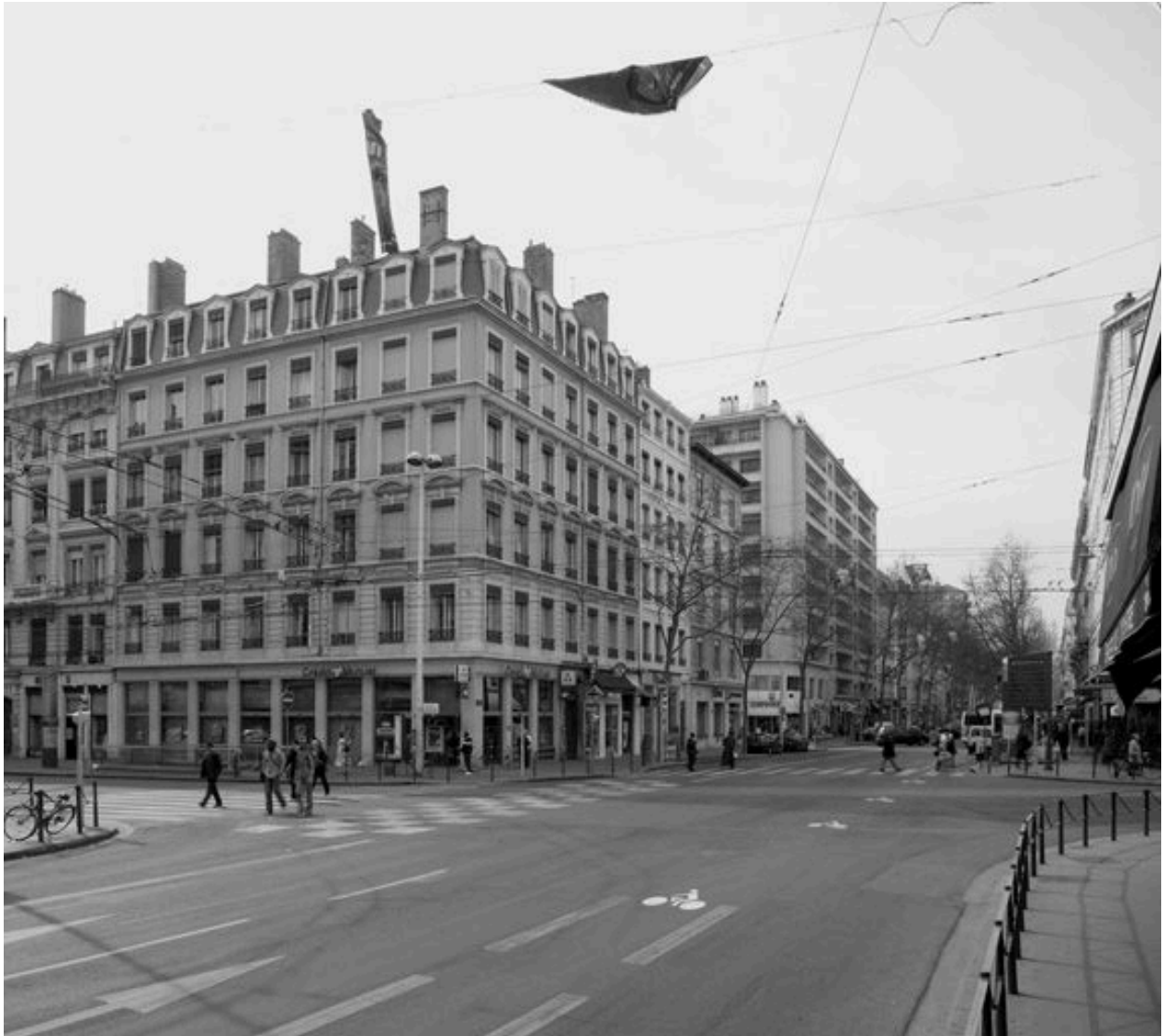
Vue générale des façades sur le cours Gambetta et l'avenue Jean-Jaurès
