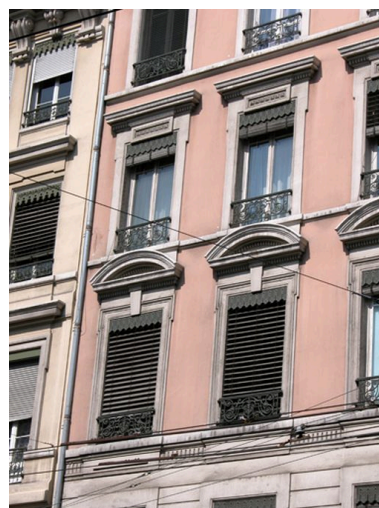
Détail des fenêtres, avenue Jean-Jaurès Phot. Maryannick Chalabi IVR82_20046904510NUCA
