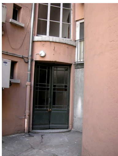
Entrée de l'escalier depuis la cour Phot. Maryannick Chalabi IVR82_20046904515NUCA
