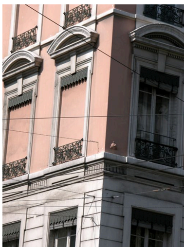
Détail de l'angle des façades cours Gambetta - avenue Jean-Jaurès Phot. Maryannick Chalabi IVR82_20046904509NUCA
