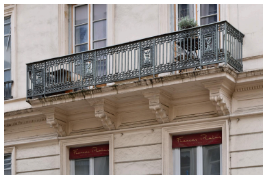
L'un des balcons sur la rue de Brest Phot. Thierry Leroy IVR84_20226900495NUCAQ
