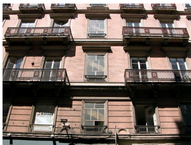
Travées centrales sur la rue de Brest Phot. Bernard Ducouret IVR82_20046905152NUCA
