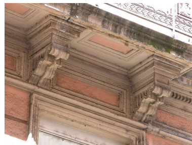
Consoles à volutes supportant la plate-forme ornée de tables du balcon Phot. Bernard Ducouret IVR82_20046905154NUCA
