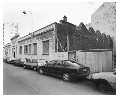
Vue nord-est Phot. Jean-Marie Refflé IVR82_20026904416V
