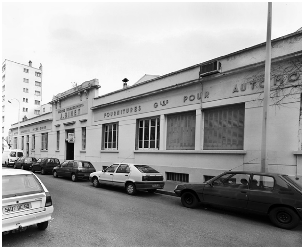
Vue générale nord
