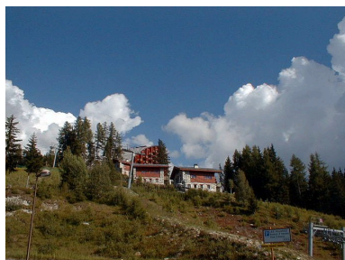
Vue d'ensemble depuis le sud-ouest Phot. C. Salomon IVR82_20057301490NUCA
